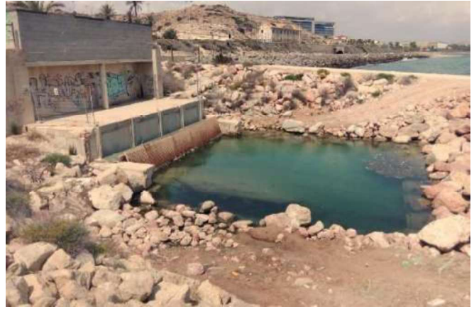
Figura 5. Detalle captación agua de mar. IDAM de Alicante 2024.
