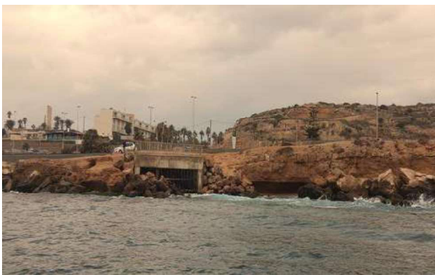
Figura 9. Detalle canal de vertido. IDAM Alicante 2024.
