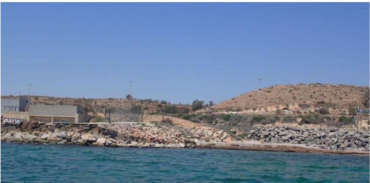
Figura 18. Detalle acumulación de arenas al norte de la estructura de captación de agua de mar. Detalle desembocadura de la rambla. IDAM de Alicante. 2025
