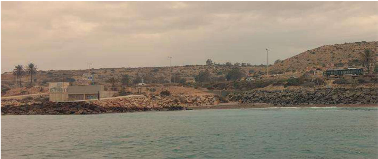
Figura 17. Detalle acumulación de arenas al norte de la estructura de captación de agua de mar. Detalle desembocadura de la rambla. IDAM de Alicante. 2024
