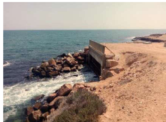
Figura 10. Detalle canal de vertido. IDAM de Alicante 2024.
