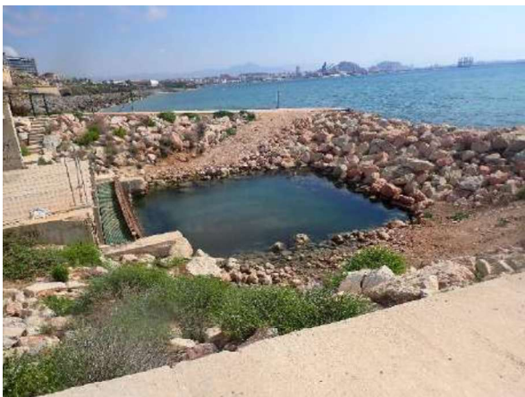
Figura 6. Detalle captación agua de mar. IDAM Alicante 2025.
