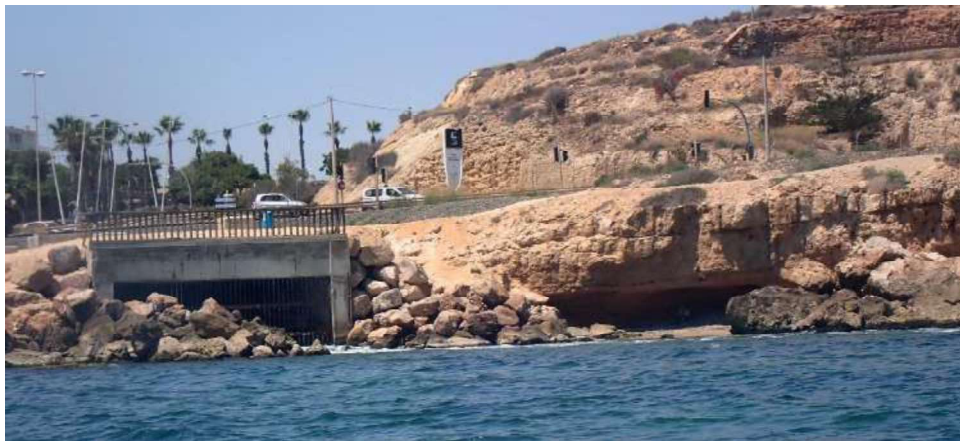
Figura 20. Detalle descabalgamiento talud al norte del canal de vertido. 2025
