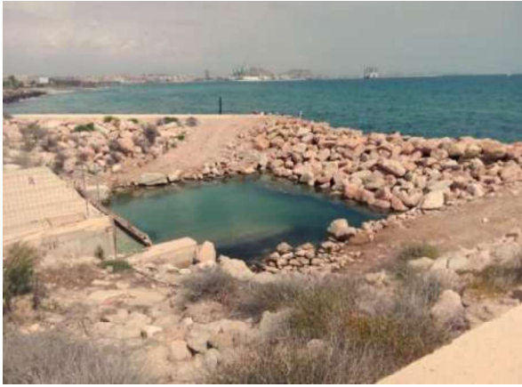
Figura 4. Detalle captación agua de mar. IDAM Alicante 2024.
