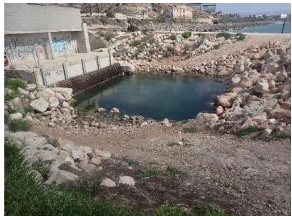
Figura 7. Detalle captación agua de mar. IDAM Alicante 2025.
