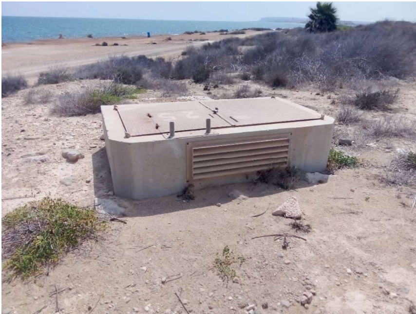
Fotografía 1 Arqueta de captación de agua marina.
