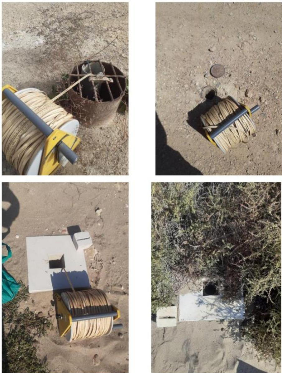
Figura 47. Piezómetros de control durante la campaña de campo de septiembre de 2025: arriba a la izquierda (D2), arriba a la derecha (P1), abajo a la izquierda (P10) y abajo a la derecha (P11).
