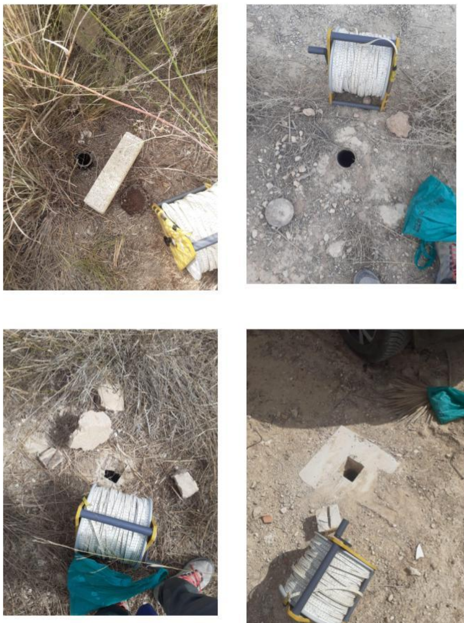
Figura 49. Piezómetros de control durante la campaña de campo de septiembre de 2025: arriba a la izquierda (P20), arriba a la derecha (P19), abajo a la izquierda (P4) y abajo a la derecha (P5).
