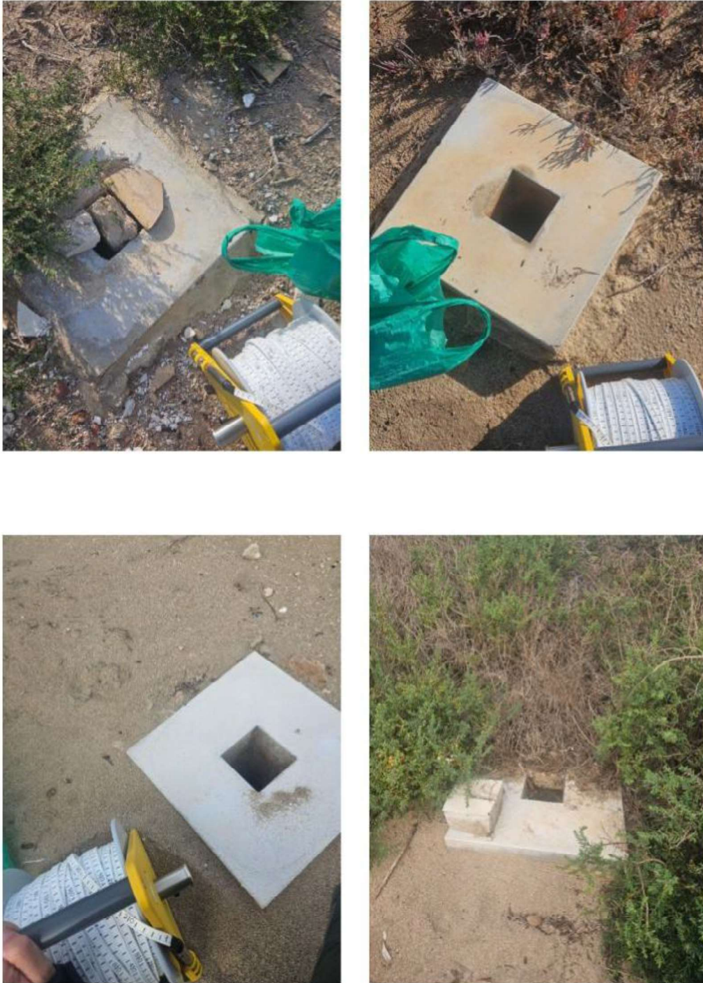
Figura 2. Piezómetros de control durante la campaña de campo de diciembre de 2025: arriba a la izquierda P7, arriba a la derecha P8, abajo a la izquierda P10 y abajo a la derecha P11.
