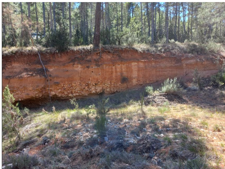
Figura 10. Erosión en margen derecha
