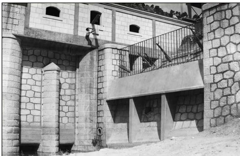
Figura 2. Entrada a la cámara de toma en margen derecha. Fuente: MCT
