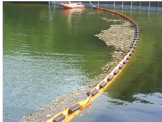
Detalle del tipo de barrera antiturbidez a colocar
