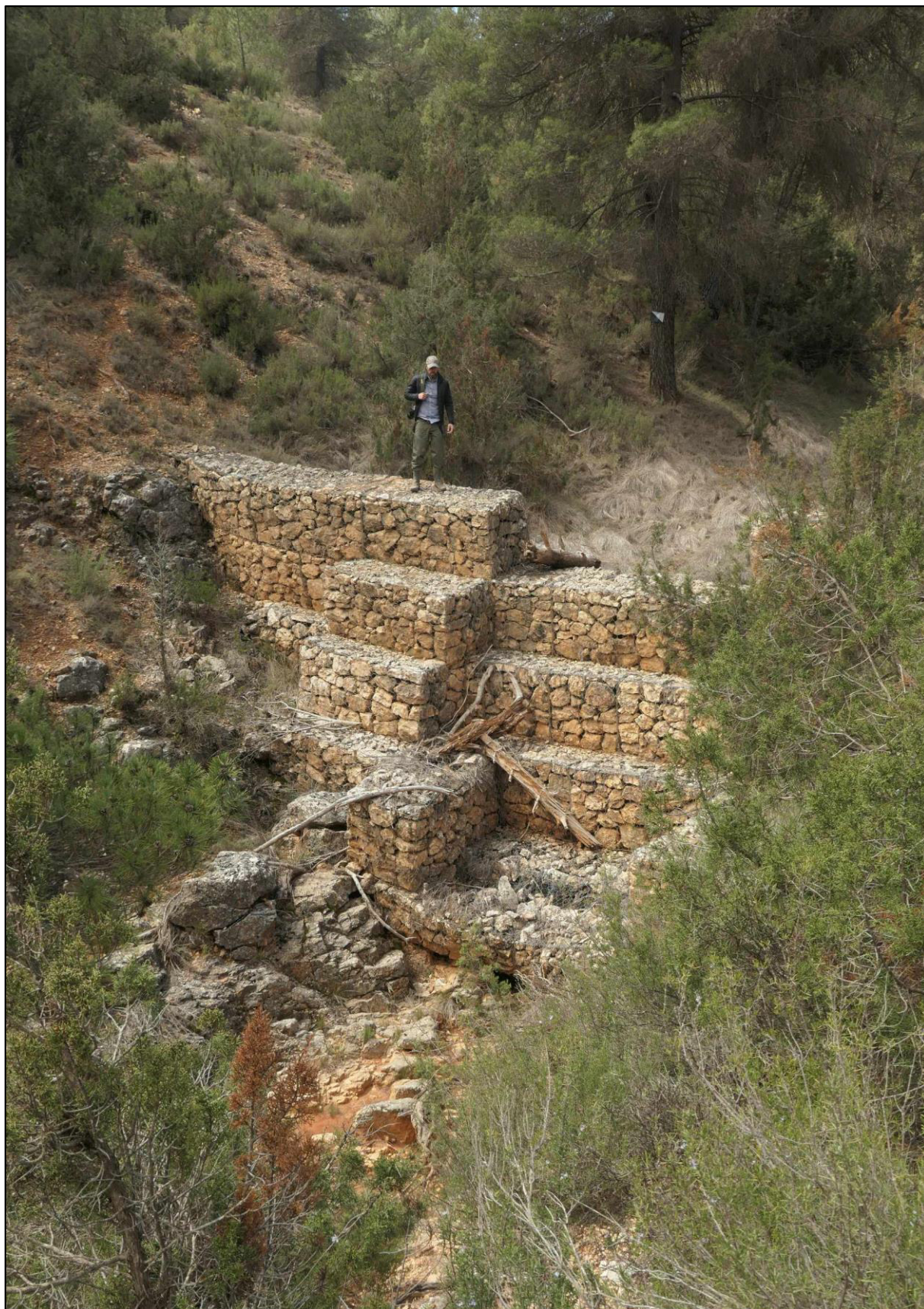
Ilustración 29. Detalle del dique 1
