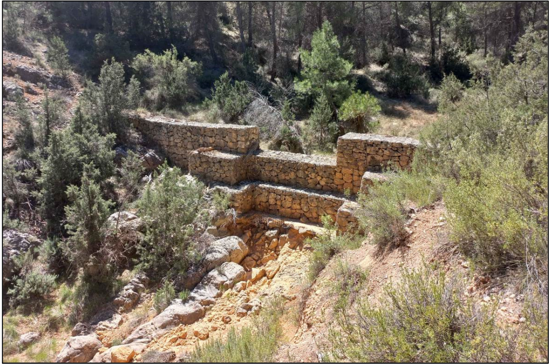
Detalle del dique Nº 2
