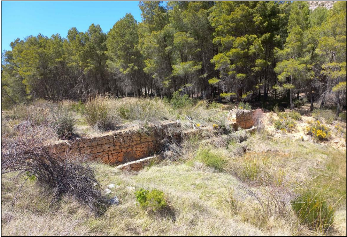
Detalle del dique Nº 4. Colmatado y naturalizado
