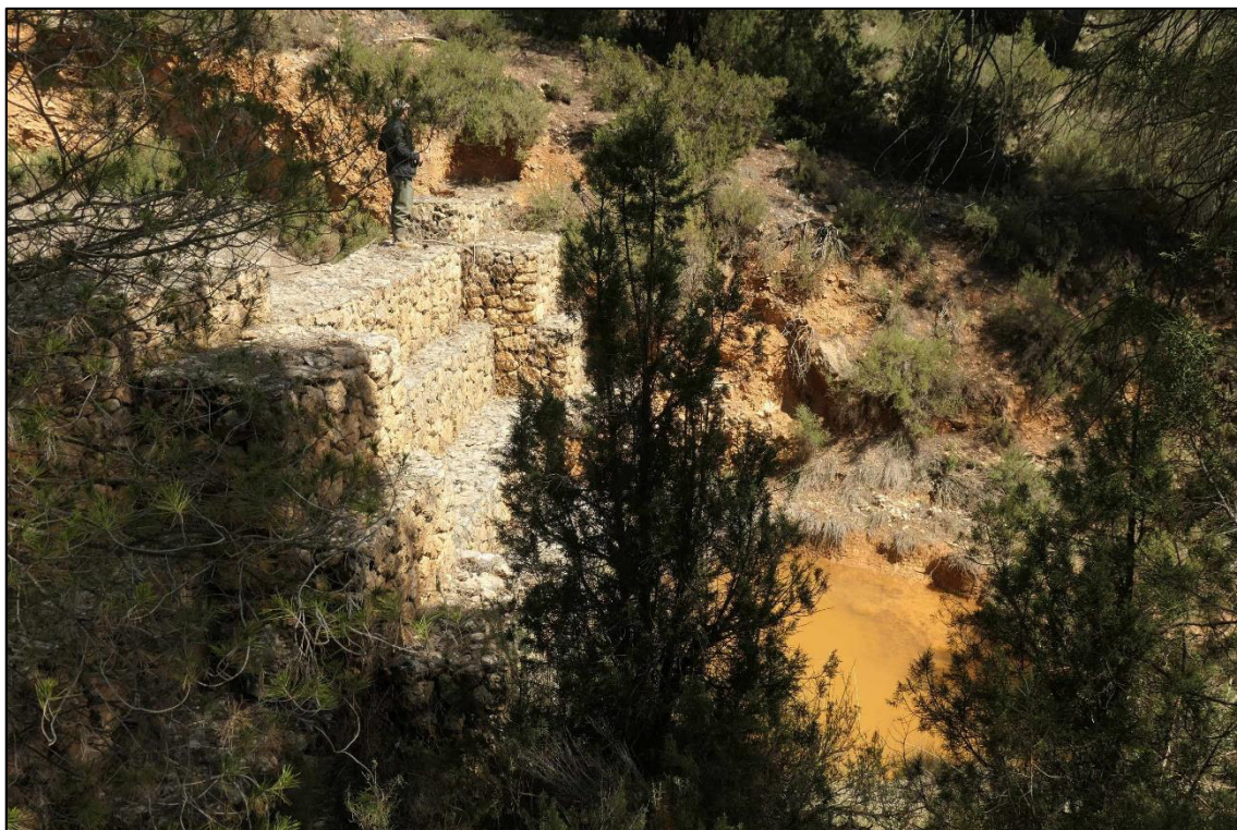
Ilustración 34. Detalle dique 3 (sin cuenco amortiguador)
