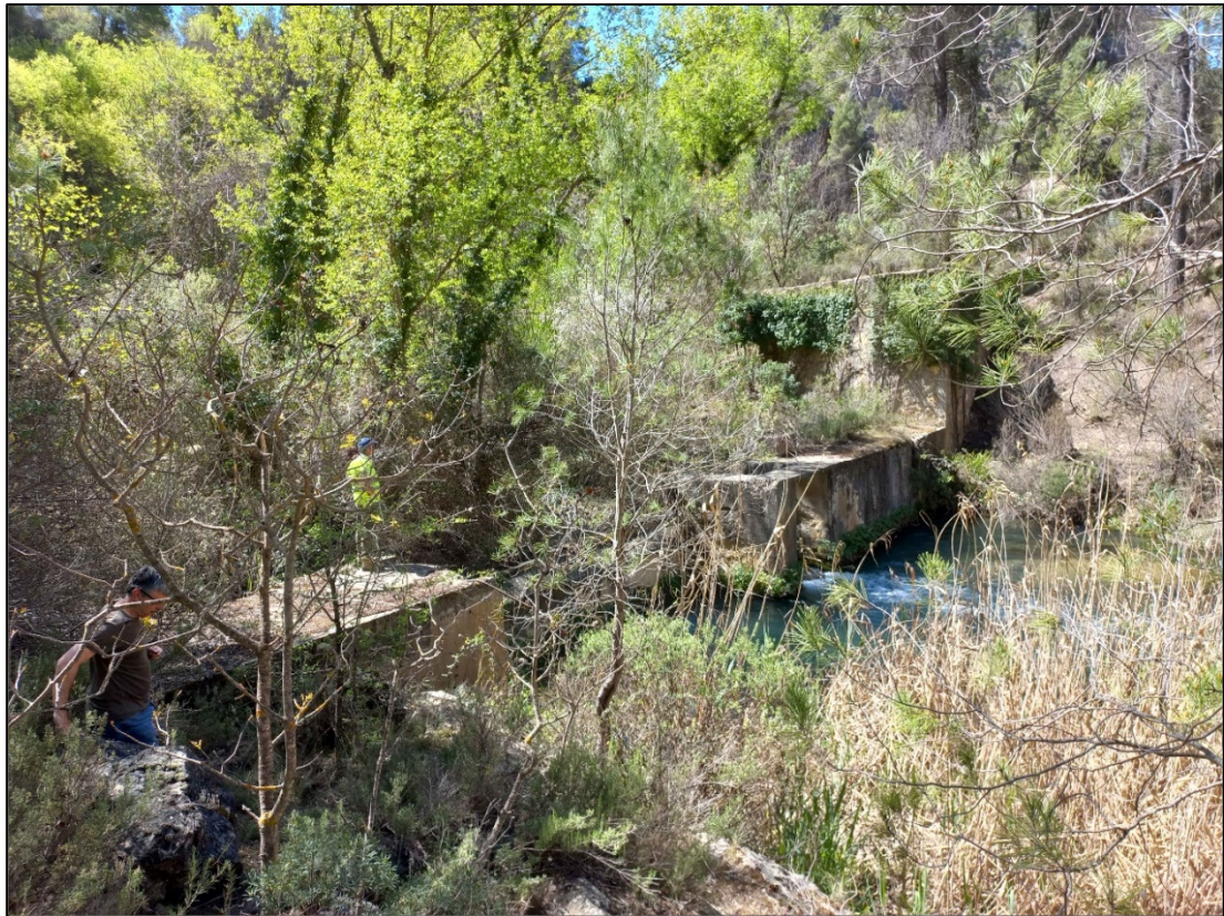
Antigua infraestructura en la cola del embalse, en desuso (no se actúa)
