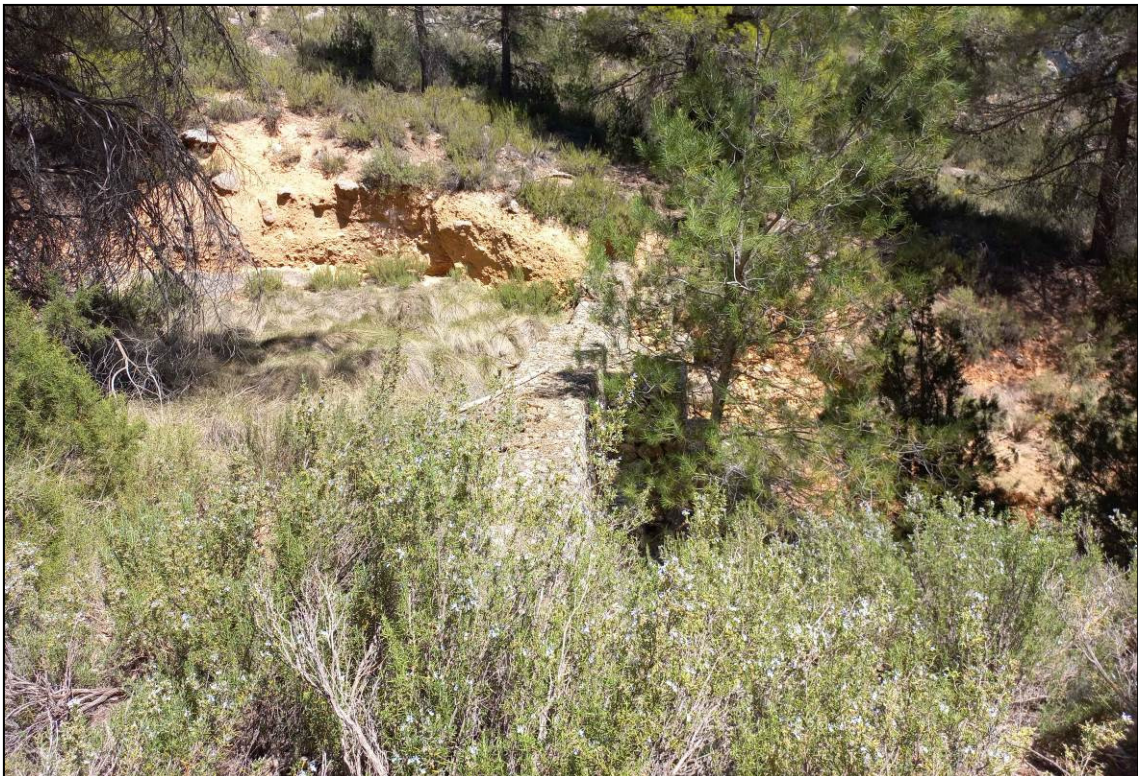
Detalle del dique Nº 3
