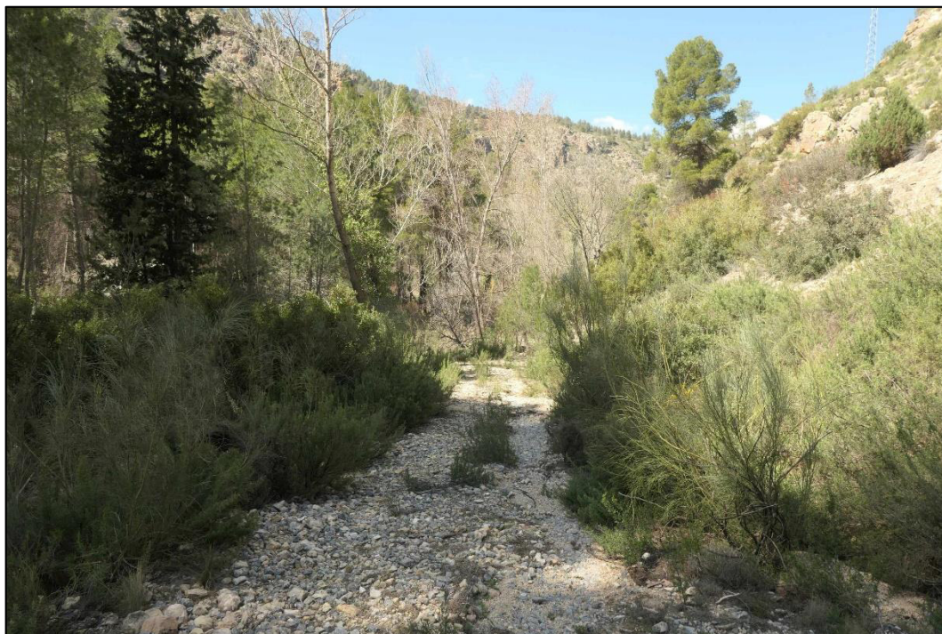
Ilustración 12. Detalle del final del tramo 1
