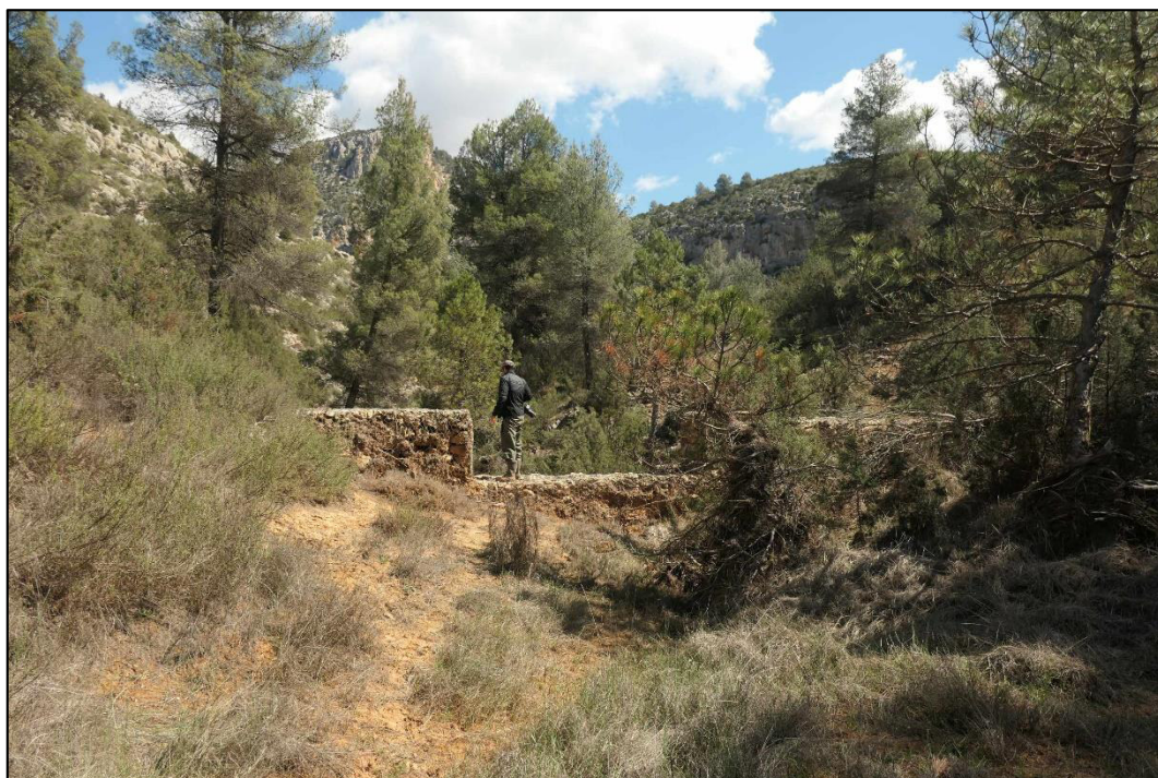
Ilustración 31. Detalle dique 2 aguas arriba (colmatado)
