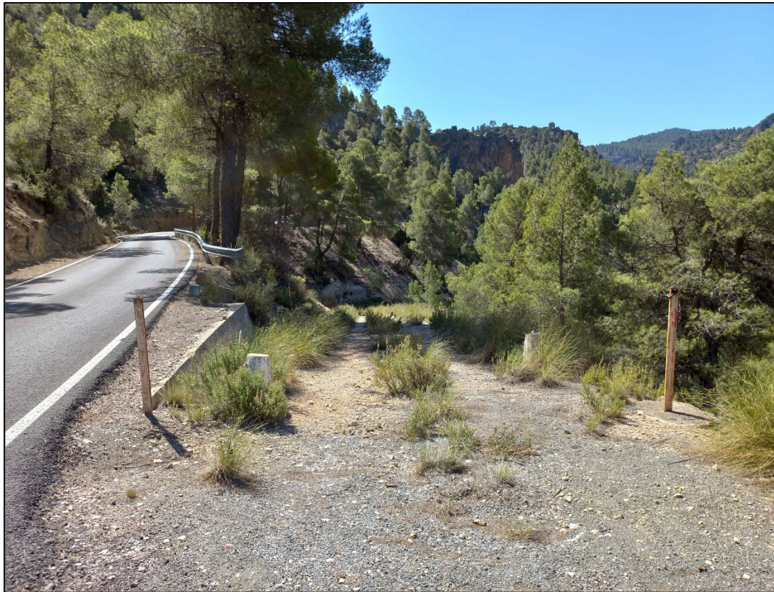
Inicio antigua pista de entrada de maquinaria al vaso
