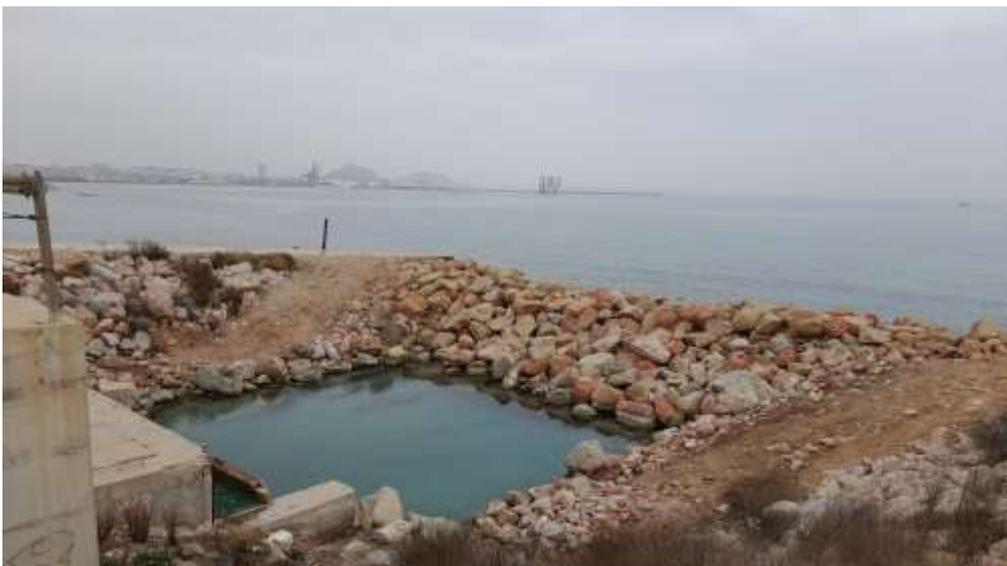
**Figura 79.** Toma de agua para la dilución del vertido
