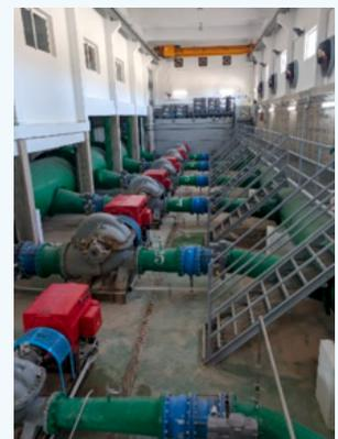
**Imagen 29.** En la planta potabilizadora (ETAP) de Torrealta se va a adecuar la línea de agua para operar con los caudales requeridos por las nuevas condiciones de explotación, en los periodos en los que el trasvase Tajo-Segura se vea muy reducido o anulado, el cual se ha establecido en un mínimo de 500 m<sup>3</sup>/h, consiguiendo una gestión más eficiente de la línea de agua de la ETAP
