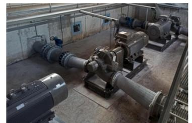
**Imagen 26.** Nuevos equipos electromecánicos instalados en la elevación de Apolonia (Lorca) para la mejora de la eficiencia energética. (Actuación en ejecución durante 2021).
