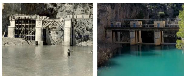
Imagen 5. La “Presa de la Toma” es un azud para la derivación de los caudales del río Taibilla. Fue de las primeras infraestructuras que se planificaron para el servicio de suministro que ofrece la MCT. La primera fotografía corresponde a su construcción (año 1944). La segunda imagen es actual.
