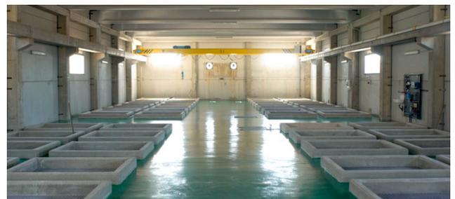
Imagen 14. Instalación de lechos de calcita en la IDAM de Alicante II, en la que se produce la remineralización del agua desalinizada.
