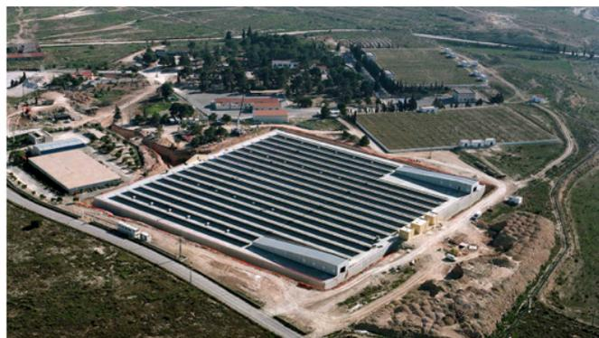
**Imagen 17.** Vista de la instalación fotovoltaica en la cubierta del depósito de Rabasa (Alicante). Ésta fue la primera instalación fotovoltaica (de 797,64 kWp). Se trata de la única planta del organismo cuya producción se destina íntegramente a la venta de energía.
