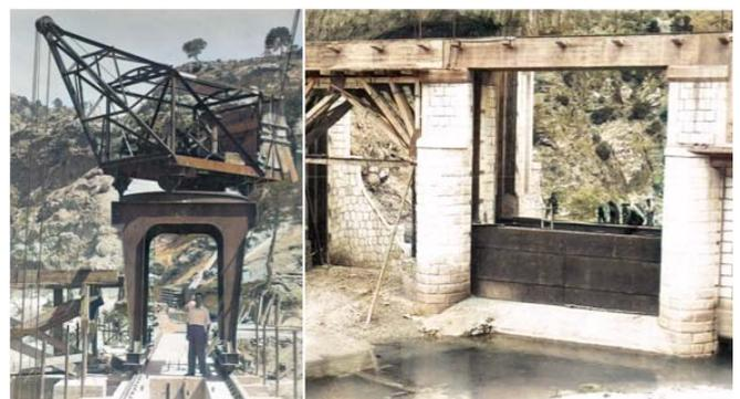
Imagen 1. La Presa de la Toma actúa como dispositivo de entrada, por aliviadero, al origen del Canal Alto del Taibilla. En las imágenes se observa la instalación de una de las compuertas en dicha Presa, en el verano de 1944. (Archivo MCT, imágenes coloreadas por IA).
