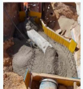
profundidad mínima de 1 m desde la generatriz superior de la conducción, con una longitud total de conducción de 3.257 m. La nueva tubería se aloja en la mayor parte del trazado en la zanja a donde estaba instalada la tubería de fibrocemento DN300, por lo que se ha procedido a su retirada.
