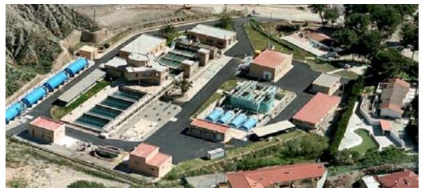
**Imagen 10.** ETAP de la Lorca (1989, Región de Murcia). En 2023 ha comenzado la redacción del proyecto de adecuación de la fase de decantación II, que permitirá restituir la capacidad de tratamiento de agua potable de la ETAP
