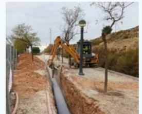
Conducción de impulsión DN350 FD, con una longitud de 1988 m desde nueva elevación de Crevillente hasta las nuevas entradas a cada uno de los vasos de los depósitos de Agrupación de Crevillente de la MCT.
