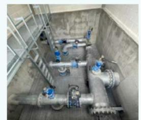
Asimismo, se ejecutará una caseta de conexión junto al antiguo arquetón existente, de dimensiones interiores 6x4 metros y 3 metros de altura, con un foso de 3,5 metros de profundidad, en la que se integrarán todas las válvulas de las conexiones entre ambos ramales, asegurando que todas las posibles salidas (Tubería DN300, Tubería DN400 y Nueva toma de Barrio de San José) puedan alimentarse desde ambos ramales de forma independiente.
