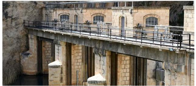
Imagen 4. Presa de la Toma (1942), situada aguas abajo del Estrecho del Aire, en el río Taibilla, actúa como dispositivo de entrada, por aliviadero, al origen del Canal Alto del Taibilla. Su construcción se inició en 1934.
