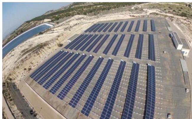
Imagen 16. Vista de la instalación fotovoltaica en la cubierta del depósito de Vistabella (Jacarilla, Alicante), construido en 2008 para regular el agua desalada procedente de las IDAM de San Pedro (MCT) y Torrevieja (ACUAMED).
