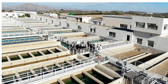
Imagen 9. ETAP de la Pedrera (1980. Jacarilla, provincia de Alicante). En 2024 finalizaron varias actuaciones con el objetivo de restituir su capacidad de tratamiento original y actualizar el sistema de filtración.
