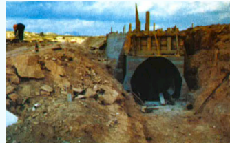
Construcción del Nuevo Canal de Murcia (1974-1977) Canal de entrada al sifón de Morcillo (Memoria MCT 1976)
