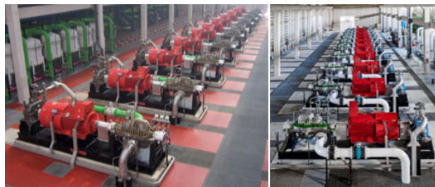
Imagen 16. Imágenes de las instalaciones de bombeo de alta presión en la IDAM de San Pedro.
