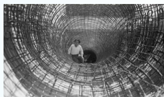
Trabajos de construcción (1933) Estructura metálica de uno de los tubos antes de su hormigonado
