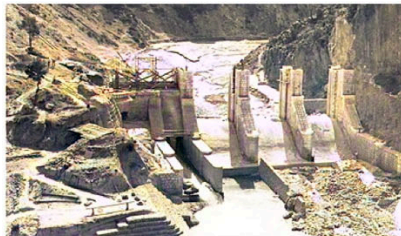
Ejecución del desagüe de fondo. Vista aguas abajo (septiembre 1943)
