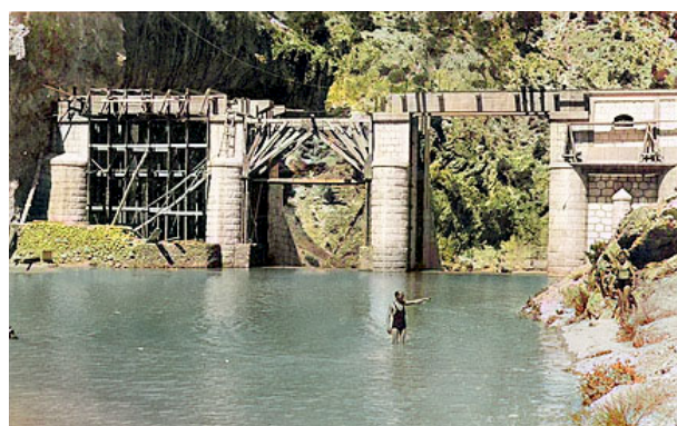
Imagen 1. La Presa de la Toma actúa como dispositivo de entrada, por aliviadero, al origen del Canal Alto del Taibilla. En las imágenes se observa la instalación de una de las compuertas en dicha Presa, en agosto de 1944. (Archivo MCT, imagen coloreada por IA).
