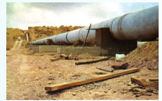
Construcción del Nuevo Canal de Alicante (1974-1977) Sifón de Rabasa (Memoria MCT 1976)
