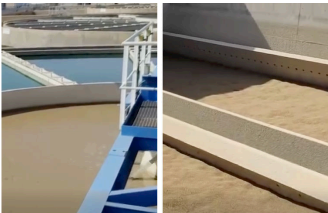
Imagen 22. Fases de decantación y filtrado en las ETAP.
