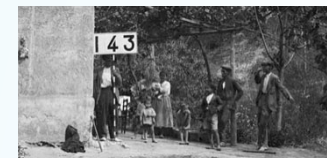
Trabajos para la elaboración del Plan General de Obras (1929-1930). Clavo de nivelación de precisión nº143. Casa del guarda de la Central Eléctrica de la Rambla de los Molinos (Alhama, Murcia)
