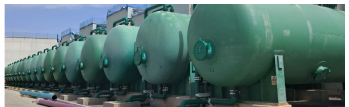
Imagen 13. Filtros de arena en la IDAM de Alicante.
