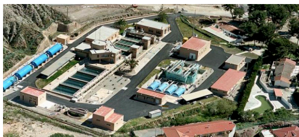
Imagen 11. ETAP de la Lorca (1989, Región de Murcia). En 2024 ha finalizado la redacción del proyecto de adecuación de la fase de decantación II, para restituir la capacidad de tratamiento de agua potable y se está redactando el proyecto de dosificación de ozono.
