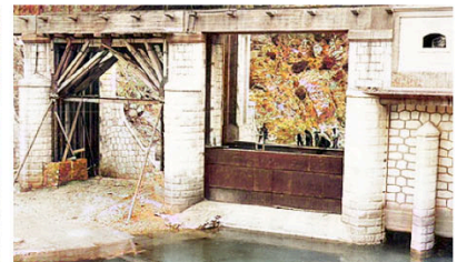
Colocación de la compuerta (septiembre 1944)
