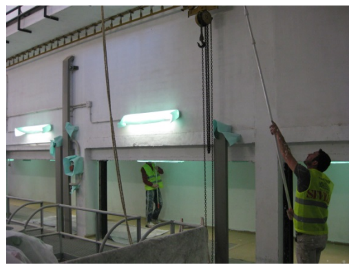
Pintado interior elevación
