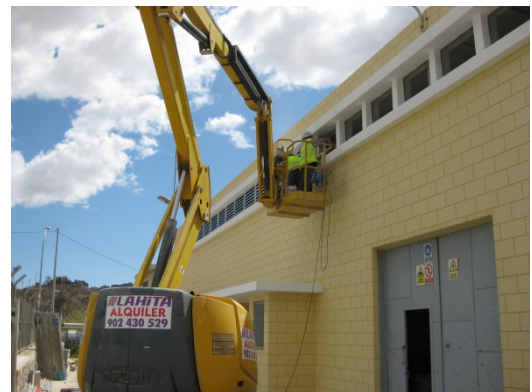
Instalación rejillas insonorizadas
