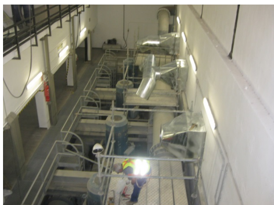
Instalación nuevo sistema ventilación bombas
