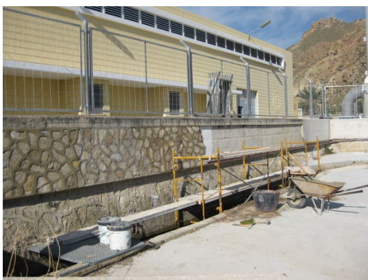
Chapado muro exterior con piedra
