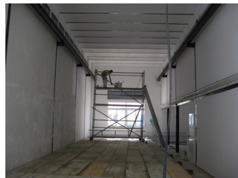
Adecuación interior elevación
