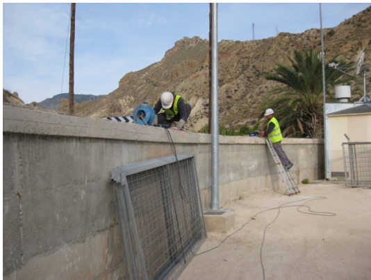
Sustitución vallado perimetral
