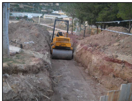
Compactación de relleno de zanja.
