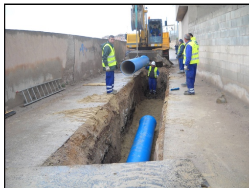
Instalación de tubería en zanja
