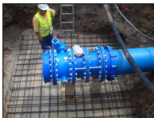
Instalación de válvulas en arqueta de corte
