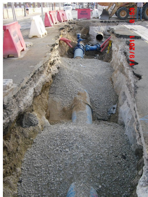
Relleno de zanja con zahorra
