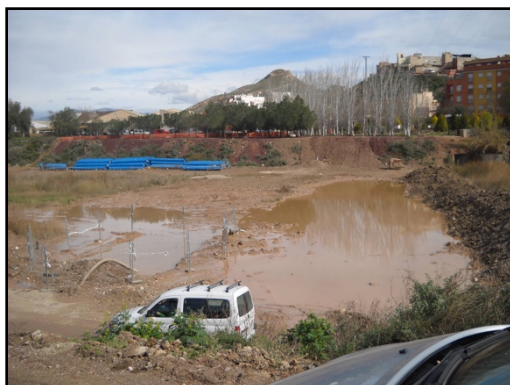
Inundación producida por lluvias
