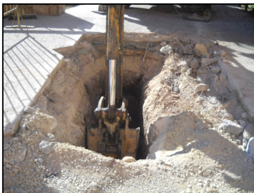
Inicio de la excavación.
