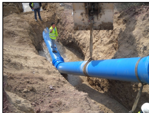
Instalación de tramo acerrojado en talud.
