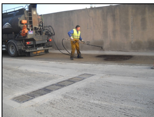
Reposición de firme aglomerado
