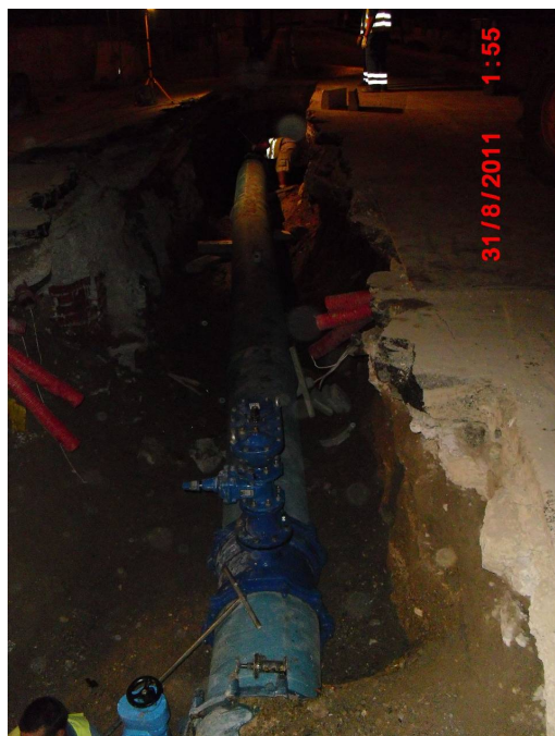
Operación de corte y conexión
