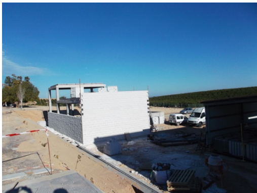
Construcción de edificio principal
