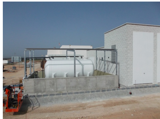
Construcción de edificio principal y cubeto de dióxido
