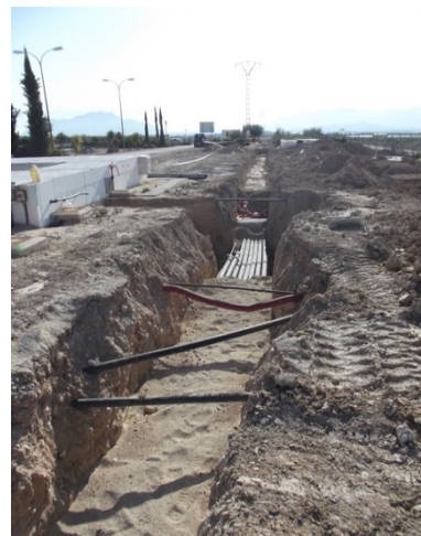
Conducciones de dosificación
