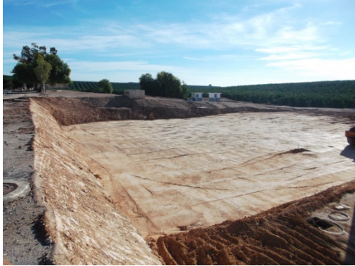
Adecuación del terreno para las nuevas instalaciones
