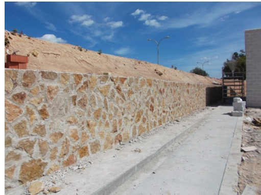
Muro de contención exterior
