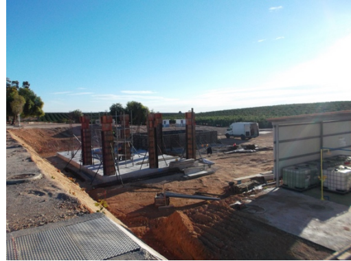
Construcción de edificio principal
