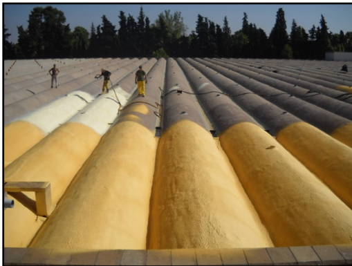
Aplicación de capa impermeabilizante.
