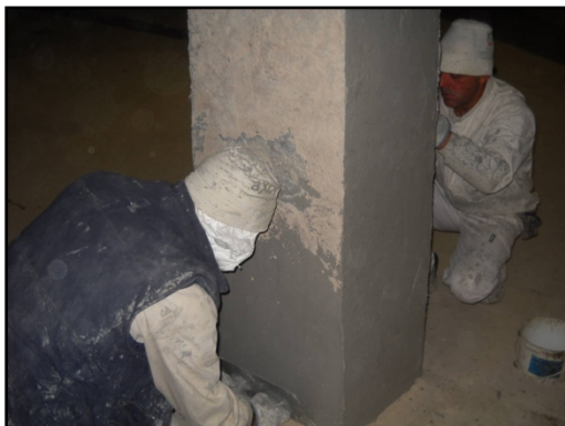
Inicio de recubrimiento de pilares.
