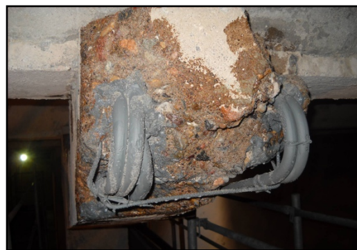
Detalle de armaduras pasivadas.
