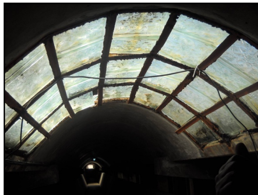
Lucernario antes de las obras.
