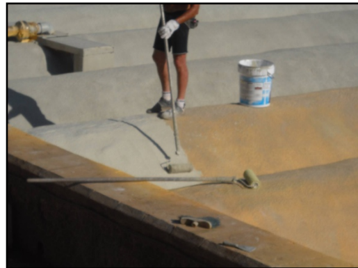
Aplicación de capa de acabado.
