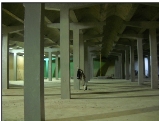
Vista del interior del depósito tras las obras.
