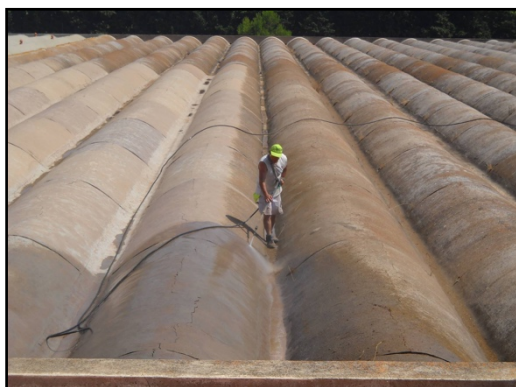
Limpieza mediante chorro de agua.
