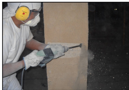
Limpieza de pilares.
