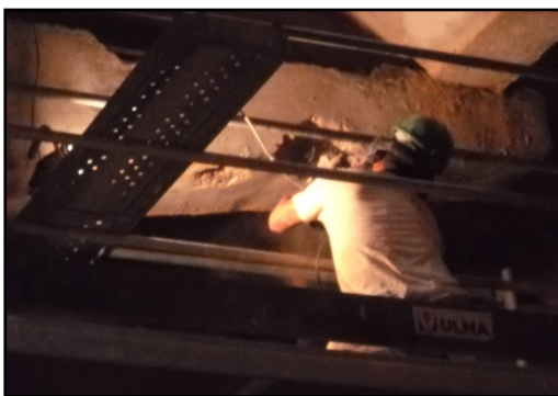
Picado para reposición de crucetas.
