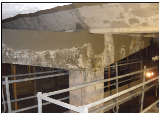
Rehabilitación de estructura de cruceta.
