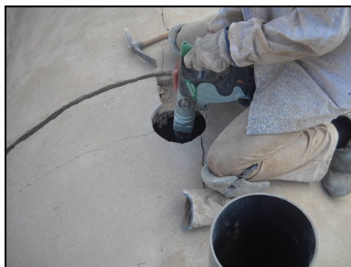
Apertura de huecos para aireación.
