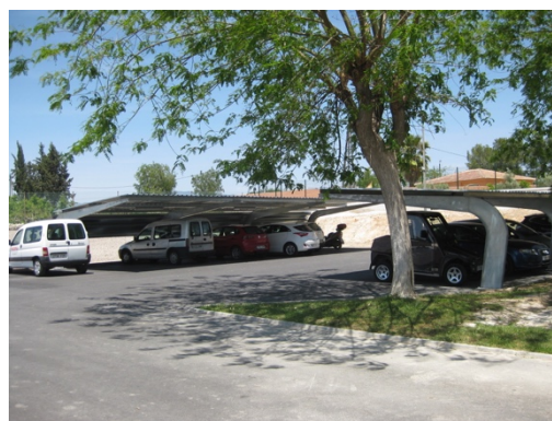
Nueva zona de aparcamiento
