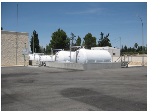
Adecuación de almacenamiento sulfato alúmina
