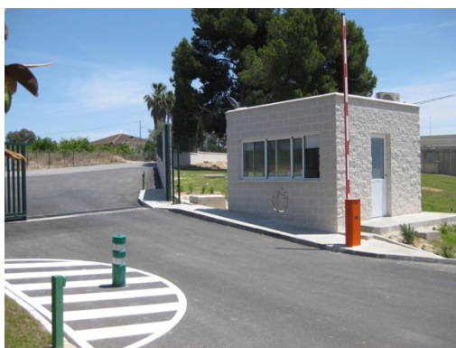
Nueva caseta de control acceso
