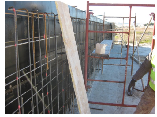
Construcción muro separación fangos
