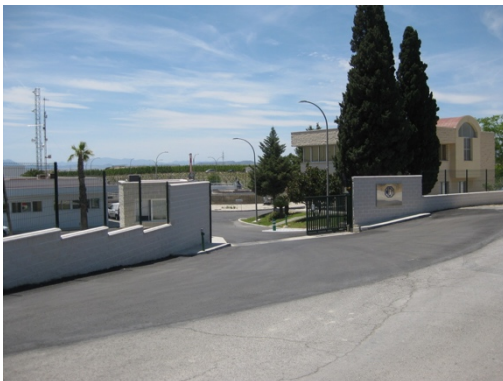
Adecuación de entrada y vallado perimetral
