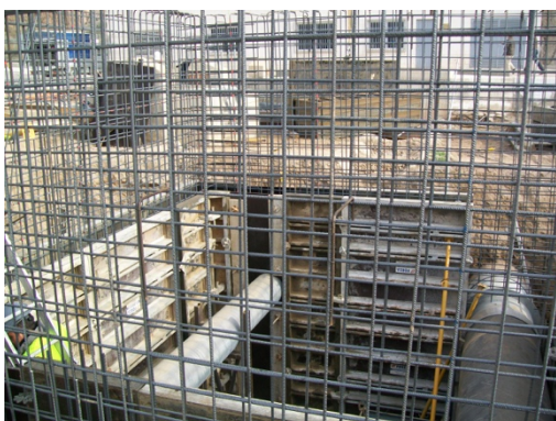
Encofrado de muros de chimenea de equilibrio.
