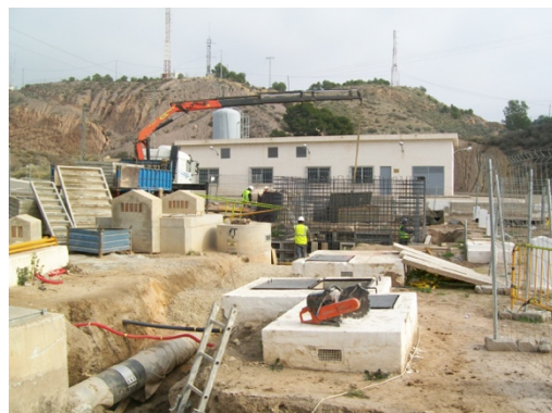
Ferrallado de muros de chimenea de equilibrio.
