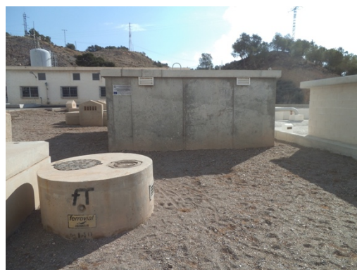
Chimenea de equilibrio terminada.
