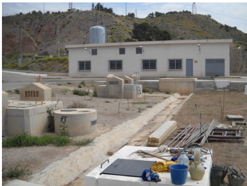
Zona de obra antes del inicio.
