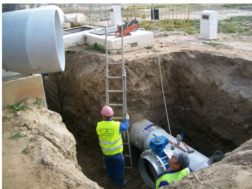
Montaje de pieza de conexión en acero galvanizado.
