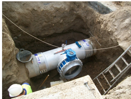
Corte de conducción e instalación de pieza en T para conexión.
