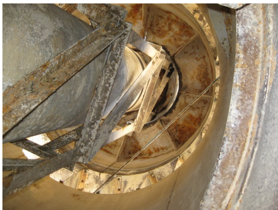
Estado inicial de los decantadores
