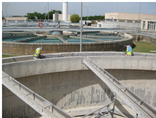
Adecuación canal recogida agua decantada
