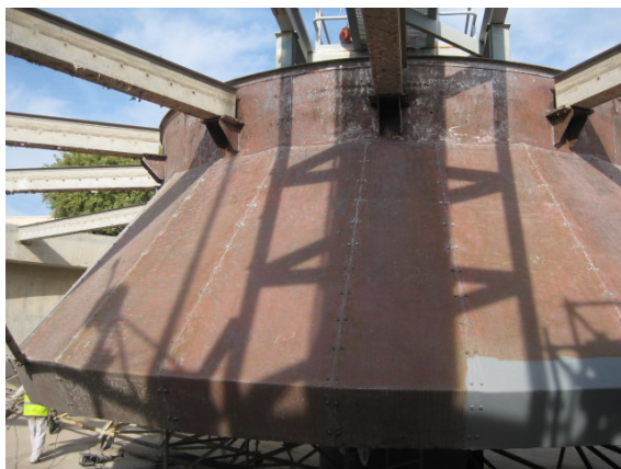
Adecuación campana decantador
