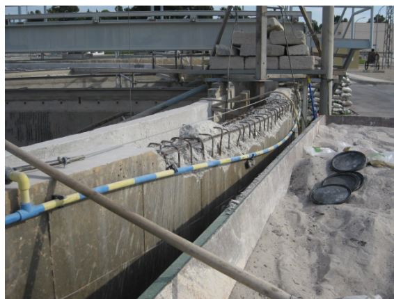
Adecuación canal perimetral decantador
