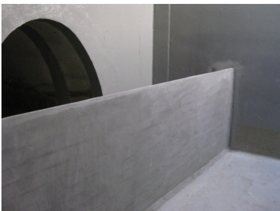
Interior arqueta derivación.
