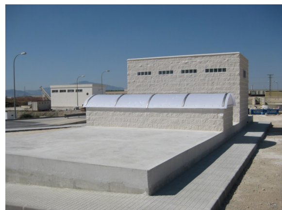
Exterior arqueta principal.
