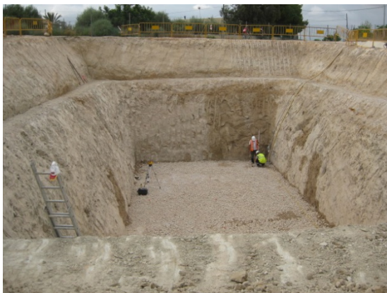
Excavación para la construcción de la arqueta.
