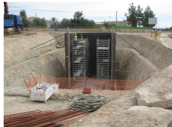
Encofrado arqueta principal.
