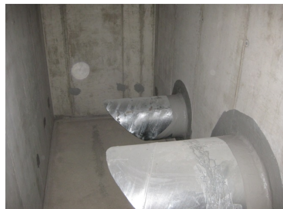
Interior arqueta principal.
