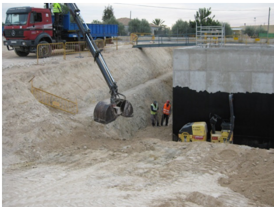
Relleno e impermeabilización.
