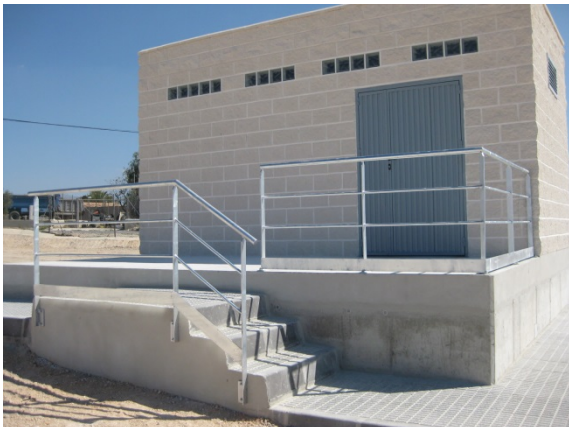
Zona de acceso interior arqueta.
