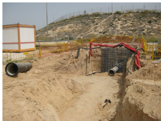
Nuevo desagüe de fondo.
