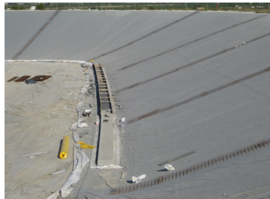
Colocación de nueva lamina y losa cortavientos.
