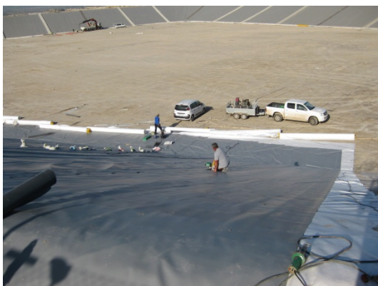
Colocación de lámina.
