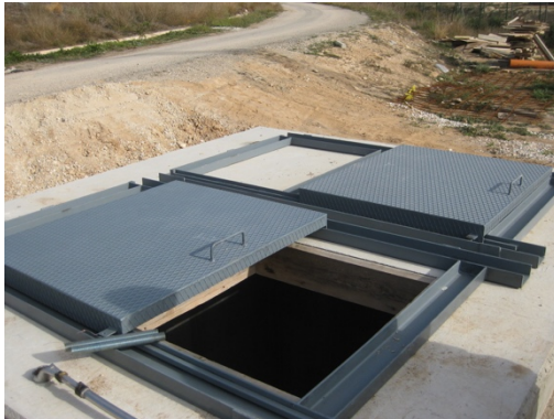
Nuevo desagüe de fondo.
