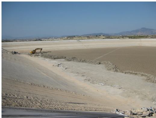
Retirada de sedimentos.
