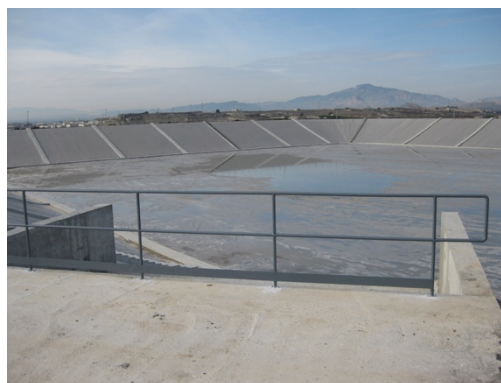
Nuevo aliviadero y vista general.
