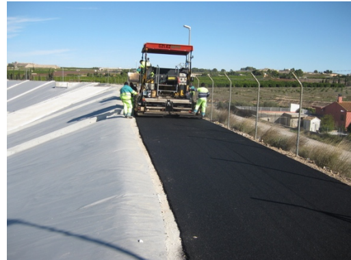
Asfaltado camino coronación.
