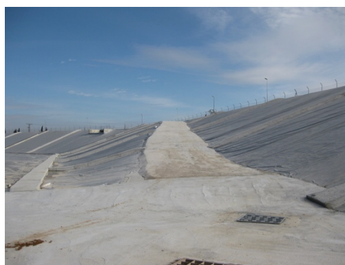
Nueva rampa de acceso a fondo de balsón.
