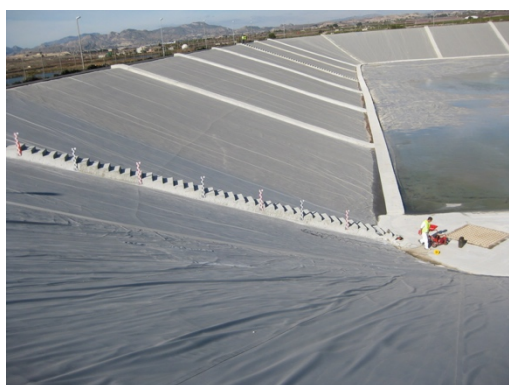
Nueva lamina impermeabilizante y cortavientos.
