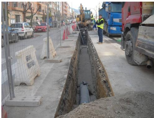
*Excavación, colocación de tubo y relleno de conducción, se observa la poca distancia entre la excavación y el relleno de la zanja.*
