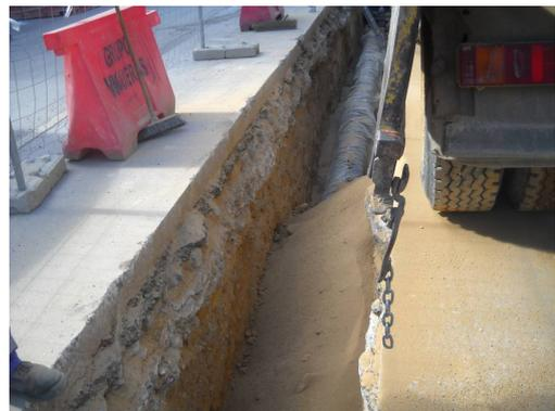
*Colocación de cama de arena en la conducción*
