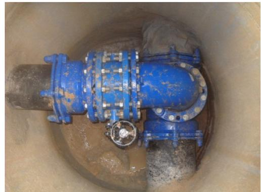
*Una de las tomas de la conducción con T de derivación 300/300/200,*
