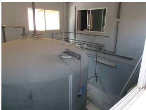
Antiguo edificio de flúor.
