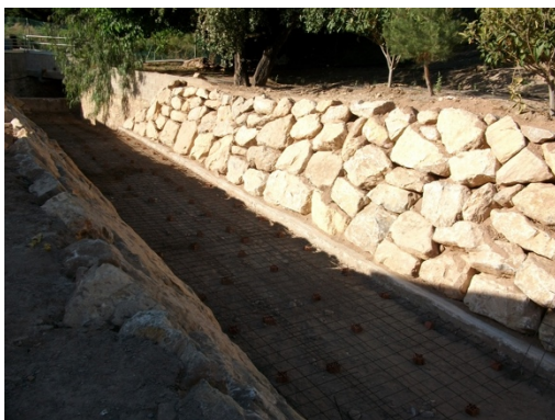
Construcción canal desagüe perimetral.
