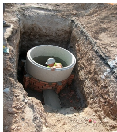
Nueva conexión alcantarillado saneamiento planta.
