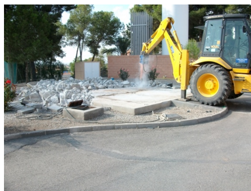
Demolición caseta control acceso.
