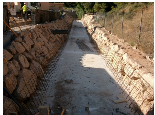
Construcción canal desagüe perimetral.
