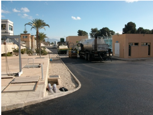
Reasfaltado interior planta.
