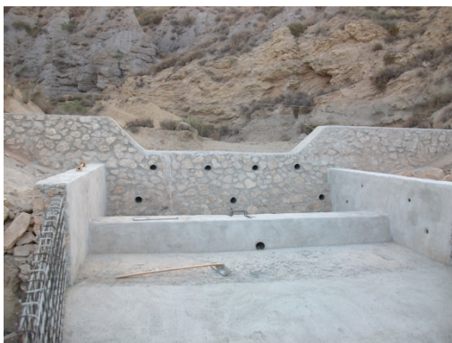
Dique contención avenidas.
