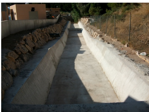
Construcción canal desagüe perimetral.
