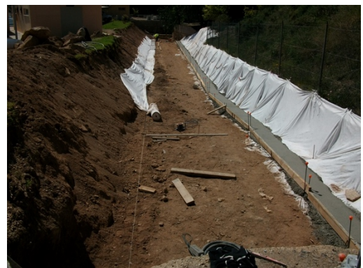
Construcción canal desagüe perimetral.
