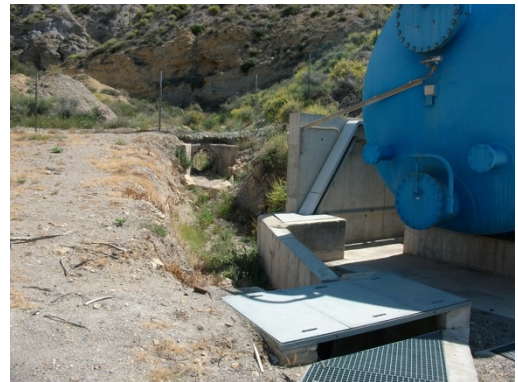
Punto de construcción de dique contención avenidas.
