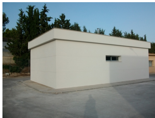
Antiguo edificio de flúor.
