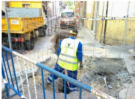
Instalación de conducción en zanja en segundo tramo.
