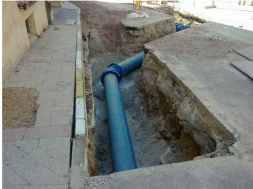
Montaje de conducción en zanja en primer tramo.
