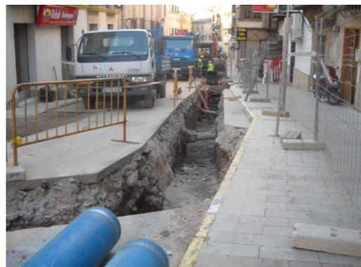
Ejecución de zanja para instalación de conducción del primer tramo.
