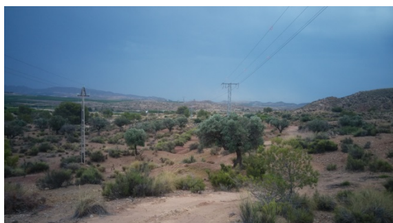
Trazado de nueva línea junto a la antigua.
