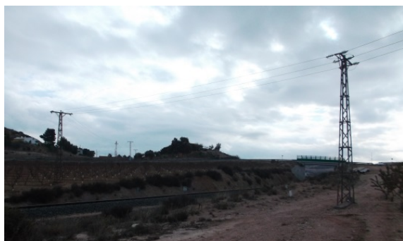
Antiguo paso sobre las vías del tren.
