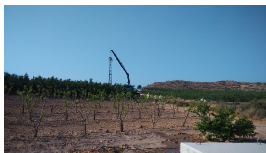
Retirada antiguo punto apoyo.
