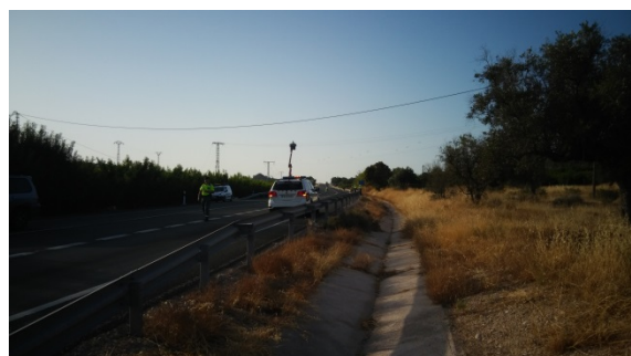
Paso de la línea sobre carretera comarcal.
