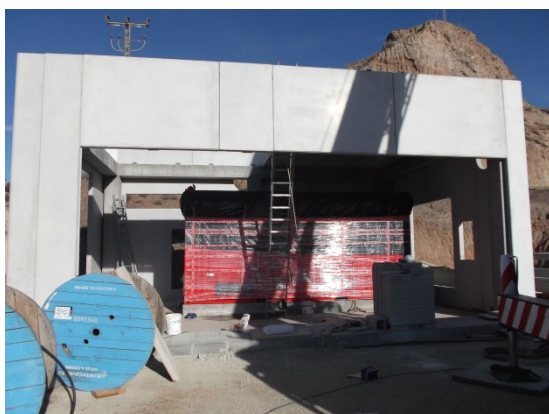
Instalación de nuevo grupo.
