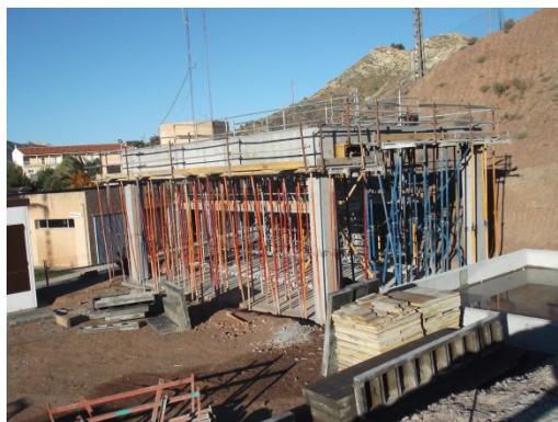
Estructura caseta grupo electrógeno.
