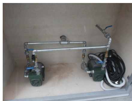
Sistema trasiego gasoil.
