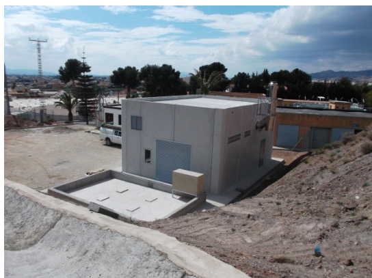
Nuevo cubeto para depósito de gasoil.
