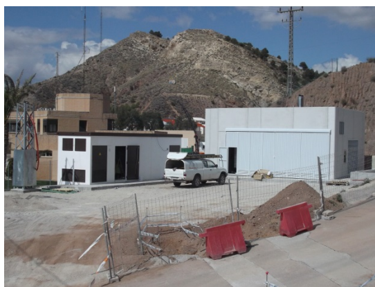
Nuevo centro transformación.
