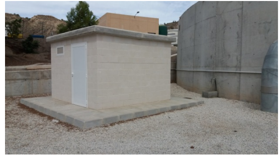
Caseta analizadores agua tratada
