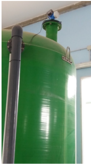
Medidor de nivel silicato
