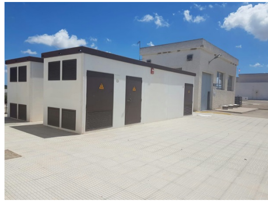
Nuevo edificio de CT y cuadros de BT
