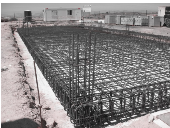
Cimentación nuevo edificio grupo electrógeno
