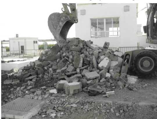
Demolición antiguo edificio grupo electrógeno
