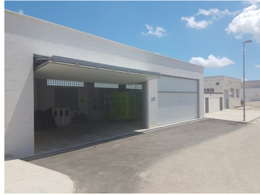
Nuevo edificio de grupo electrógeno
