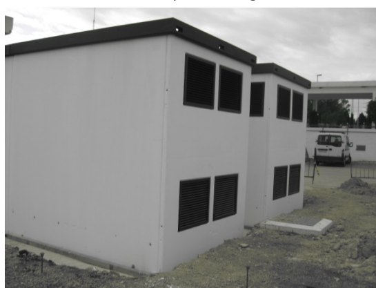
Construcción de nuevas estructuras de CT y cuadros de BT
