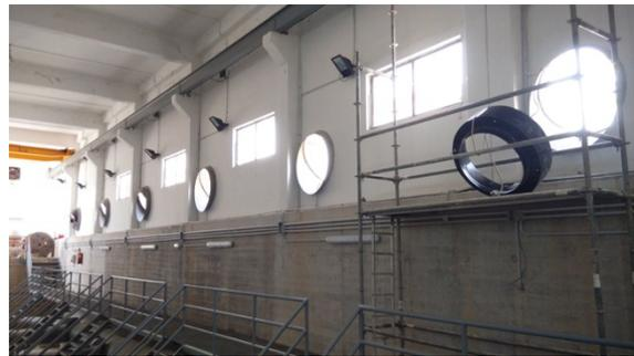
Cambio del sistema de ventilación de las bombas elevadoras.
