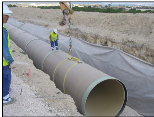
Colocación de tubos.
