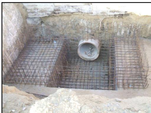
Ferrallado de solera, arqueta de toma de Torre vieja
