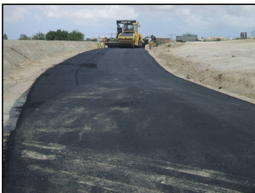
Capa de firme en camino de servicio
