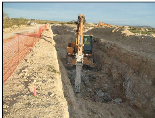
Excavación de zanja
