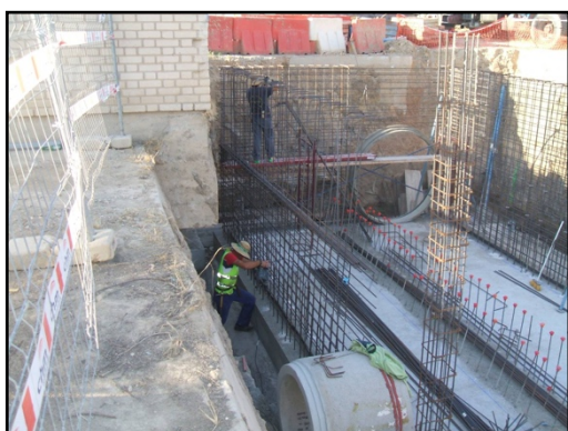
Ferrallado muros almenara
