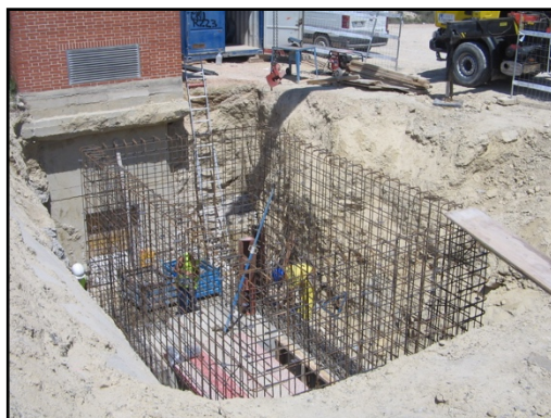
Ferrallado de los muros de la arqueta de la toma de Torre vieja.
