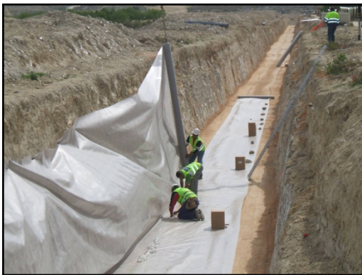
Colocación de geotextil en fondo y taludes de zanja
