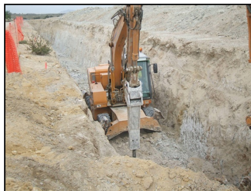
Excavación de zanja mediante martillo
