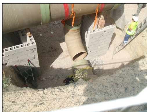
Colocación pieza en T y unión con tubo bajo hincia en toma Torre vieja
