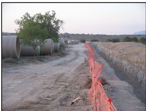
Tubos acopiados junto a zanja
