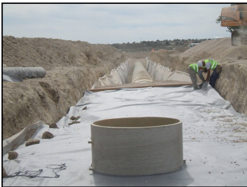
Cierre dren con Geotextil sobre pozo de registro
