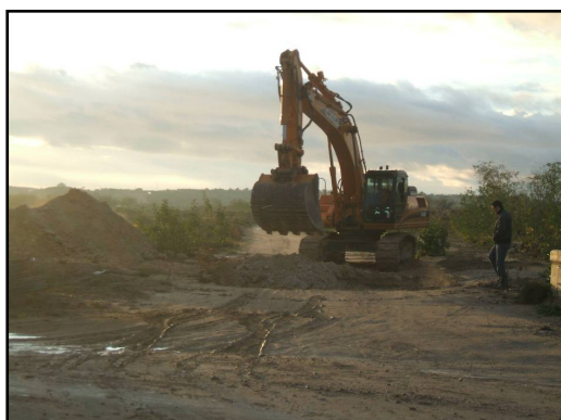
Inicio de excavación de foso de hinca
