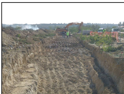
Ejecución de zanja 0+240
