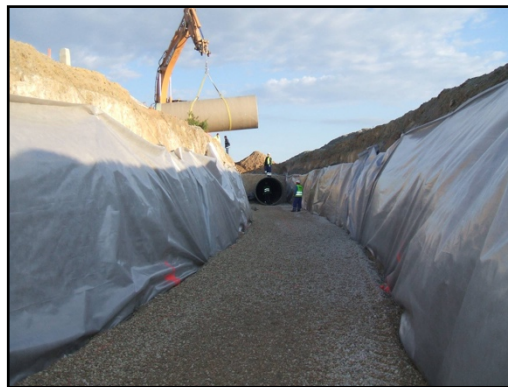
Colocación de tubos entre 0+620 y 0+810
