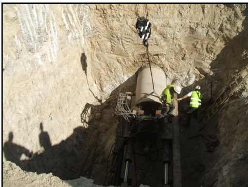
Hincado de tubos
