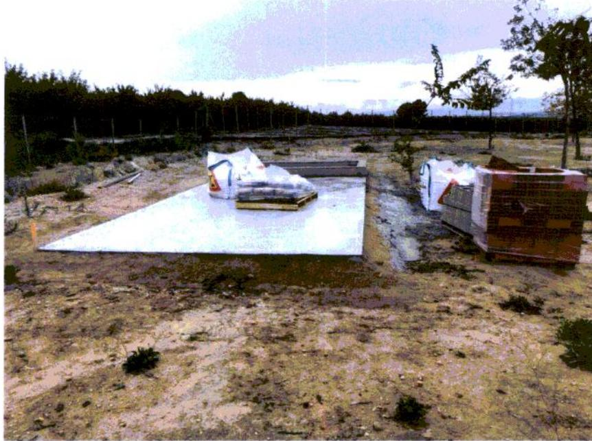
FOTO 10. Detalle del cubeto de retención de líquidos para evitar derrames al terreno.
