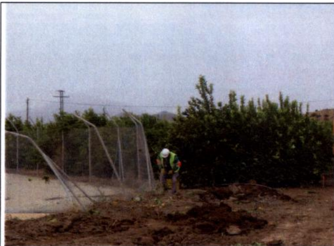
Proceso de desmontaje de las vallas perimetrales de las fincas agrícolas en las zonas de paso de la pista de la tubería.
