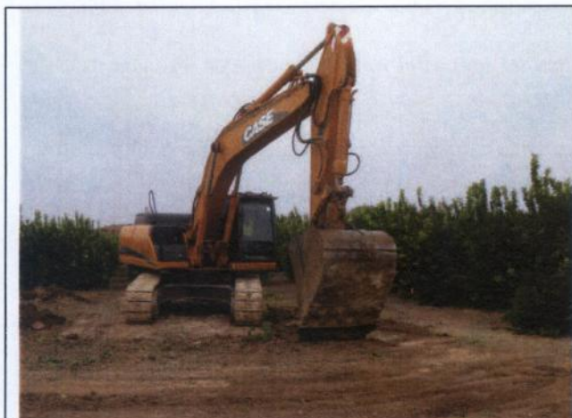
Desbroce, limpieza y alisado superficial de la pista con el cazo de la máquina.
