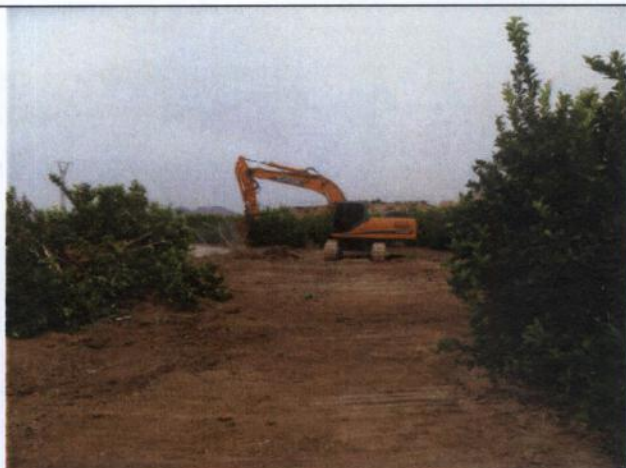
Proceso de talado por medios mecánicos (al fondo) y apertura de la pista.
