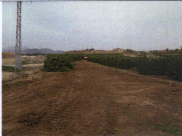
Apertura pista en el flanco N del embalse. Al fondo, máquina talando.
