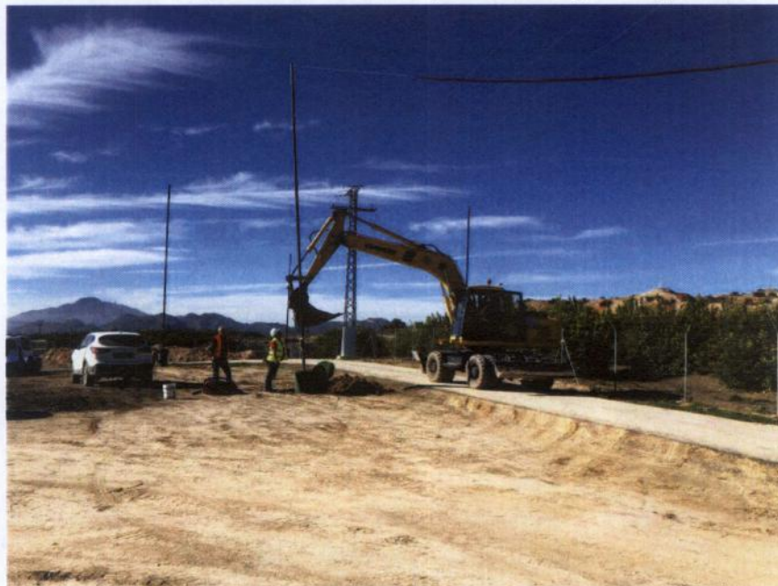
FOTO 6. Vista de trabajos de colocación de pórtico de seguridad para líneas eléctricas.
