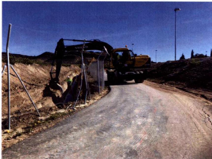
FOTO 7. Vista de trabajos de colocación de tubería y relleno de zanja
