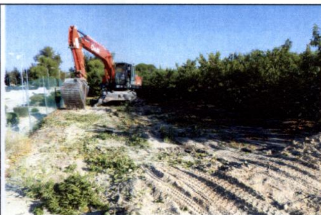
Proceso de tala y recogida de restos vegetales con máquina giratoria.
