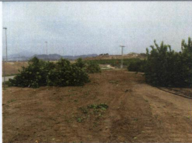
Pista en proceso de retirada árboles talados al N embalse seguridad ETAP.
