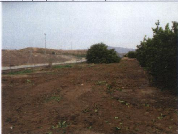
Apertura de la pista junto al vértice N del embalse de seguridad de la ETAP.
