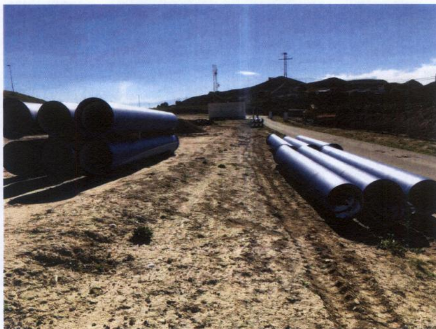
FOTO 10. Detalle de acopios de tuberías sobre suelo desnudo.
