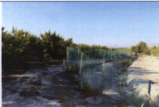
A la derecha de la valla, propiedad de la ETAP con cuneta de evacuación de aguas excavada en el terreno natural.
