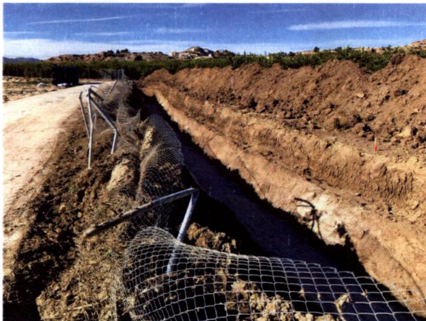
FOTO 8. Vista de la zanja una vez colocada la tubería y rellanada parcialmente. Los cordones de tierra vegetal son de altura menos a 1,5 m.
