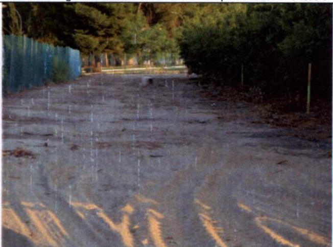
Detalle del tramo desarbolado y desbrozado con estacas del límite de obra.
