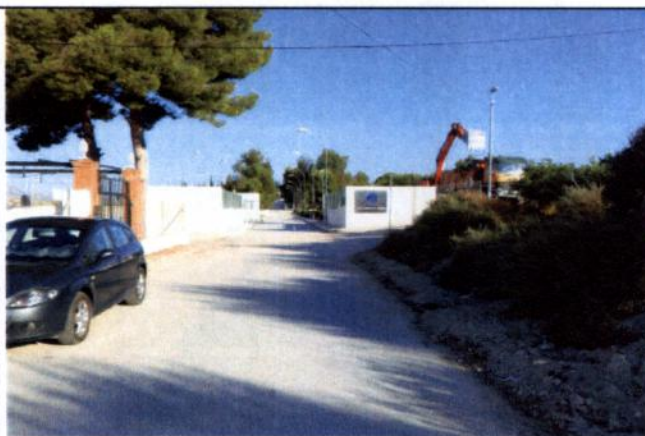
Zona inicio de obra en ETAP Sierra de la Espada
