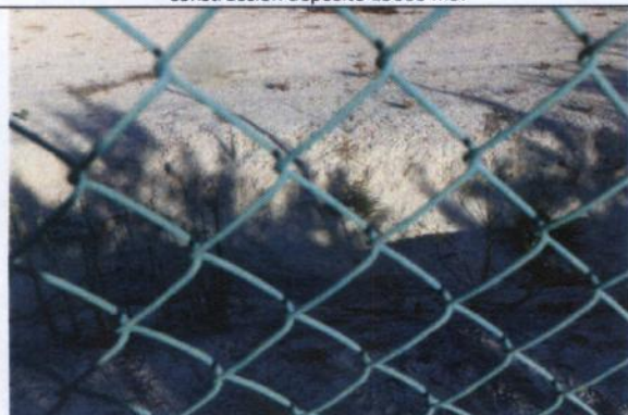
Detalle de la cuneta perimetral de la ETAP, con las margas compactas debajo de un nivel superficial arenoso.
