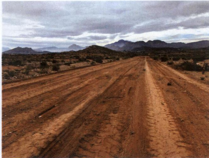
FOTO 5. Imagen de la apertura de traza en la zona entre los barrancos.
