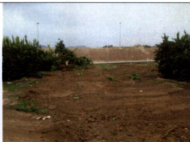
Trazado de la tubería desbrozado junto al vértice NE del embalse de Seguridad de la ETAP.
