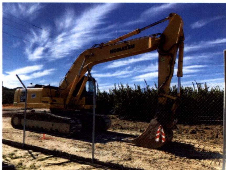
FOTO 16. Vista de la retroexcavadora trabajando en apertura de zanja en el paraje Comala.
