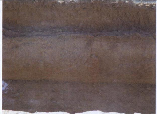
Detalle del fondo y parte inferior de la zanja con la arcilla compactada. Arriba con textura más suelta y arenosa originada por el laboreo agrícola.
