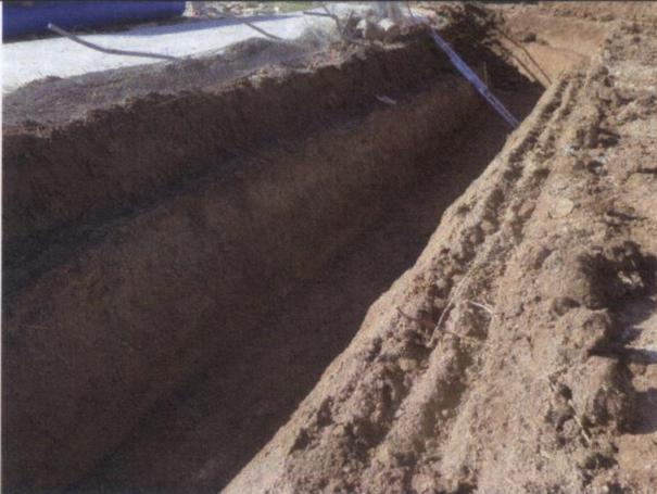
Zanja para colocar la tubería, con los márgenes provistos de sendas bermas de seguridad.
