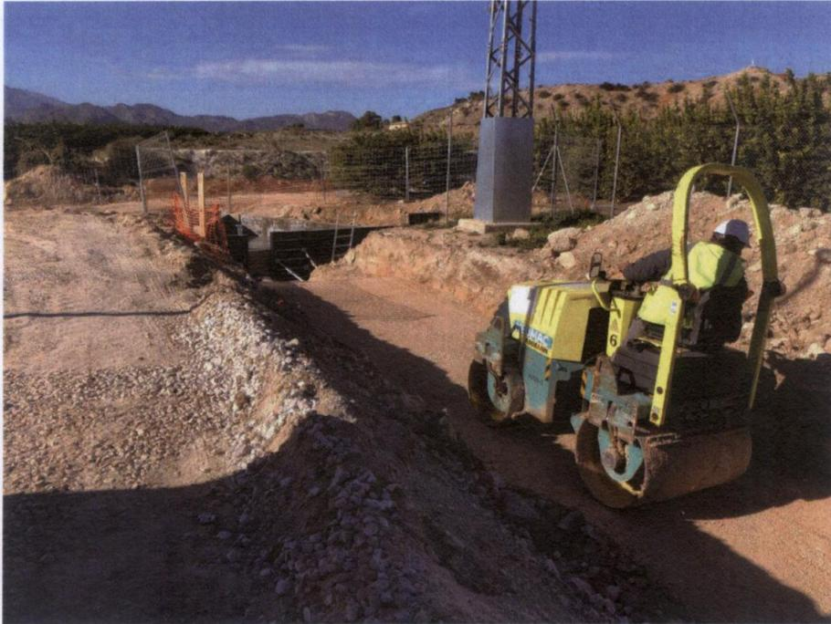
**FOTO 8. Vista de tramo de zanja tapada y compactada**
