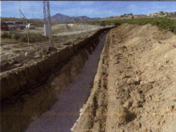
Trazado rectilíneo de la zanja con relleno de grava.
