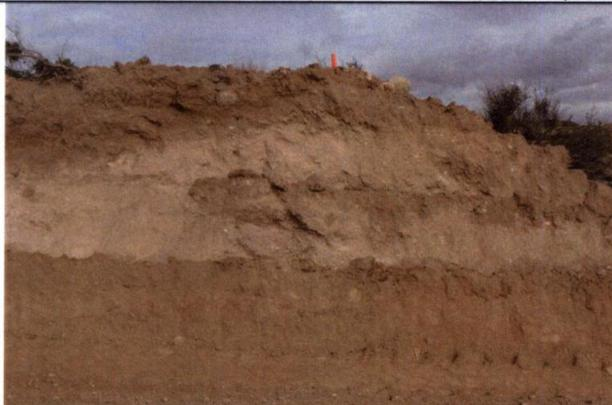
Aspecto del desmonte de la pista con niveles arcillosos con cantos en superficie.
