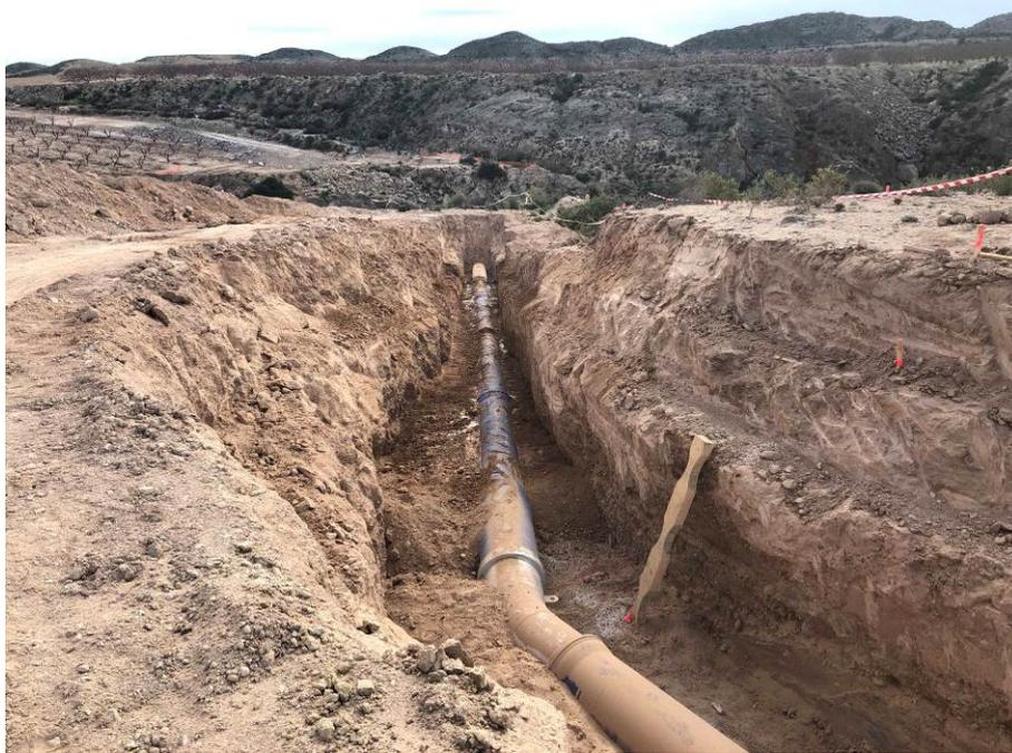
**FOTO 10.** Vista de tramo de zanja parcialmente rellena, con la tubería.
