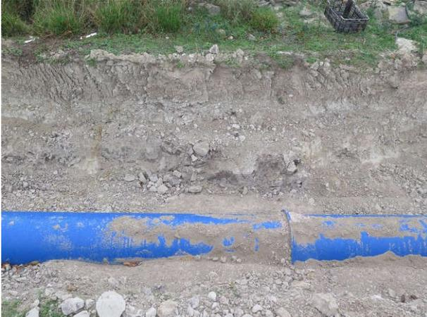
Aspecto de la tubería colocada en la zanja con relleno lateral de tierra de excavación. Sedimentación alterada por la roturación del terreno.
