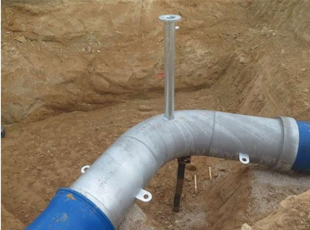
Aspecto de la pieza metálica reforzada en el cambio de dirección de la tubería, dentro de la excavación para encofrar.
