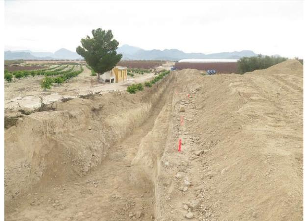
Aspecto de la ampliación de la zanja para colocación de infraestructuras de la tubería.
