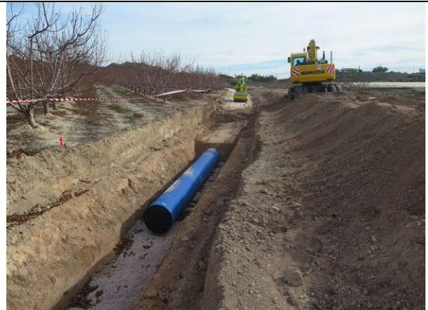
Proceso de trabajo en el que se aprecia en detalle de la zanja con la grava de base, la tubería, el relleno lateral de tierra y las capas de compactación y cierre superiores
