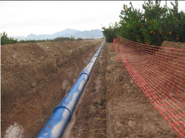
Aspecto de la tubería colocada sobre la grava previo a su relleno, entre los PP.KK. 0+925 y 1+120.
