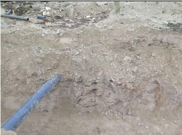
Detalle de una fosa excavada en las margas para introducir un conducto de riego.
