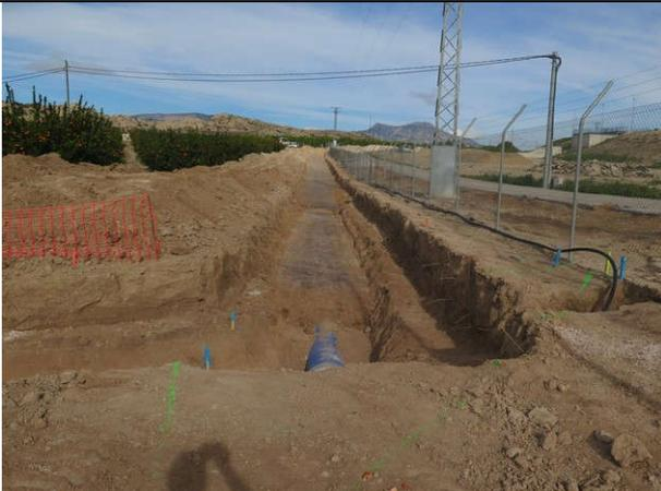
Cierre de la zanja con sedimentos procedentes de la excavación en la valla perimetral norte de la balsa de seguridad de la ETAP.
