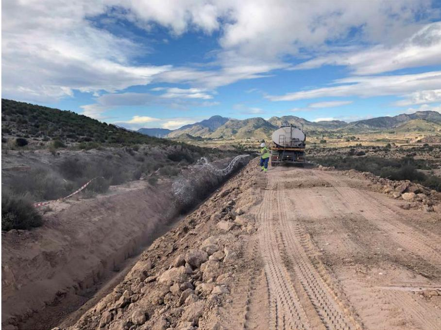
**FOTO 12.** Vista de trabajos de compactación de zanja.
