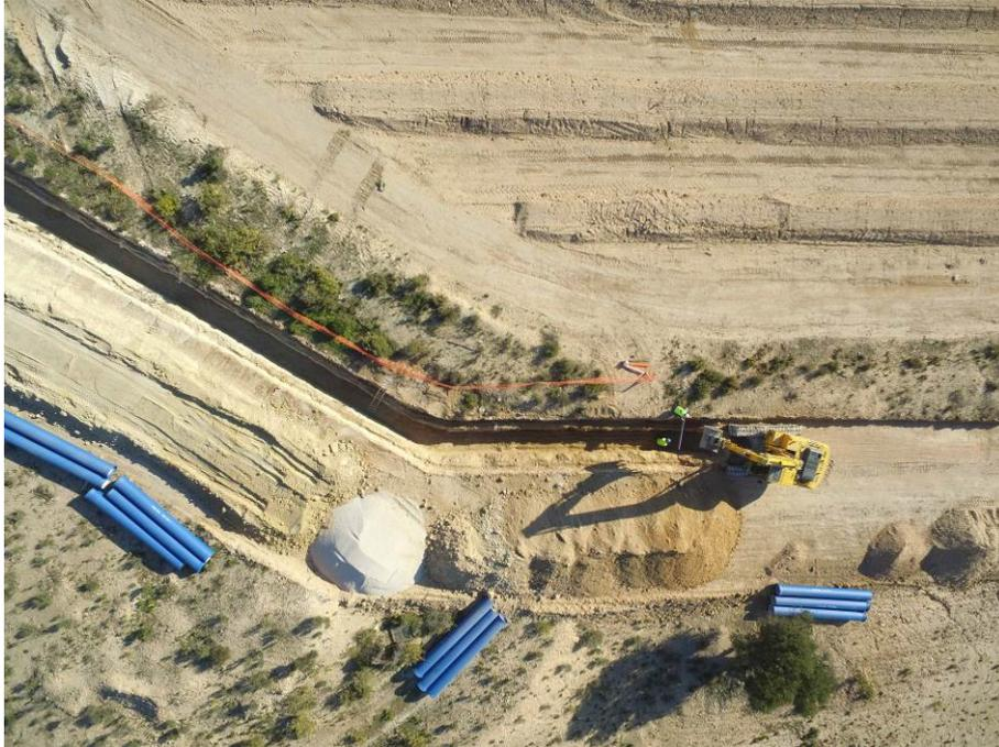
**FOTO 6.** Vista aérea de los trabajos de relleno y compactación de zanja.
