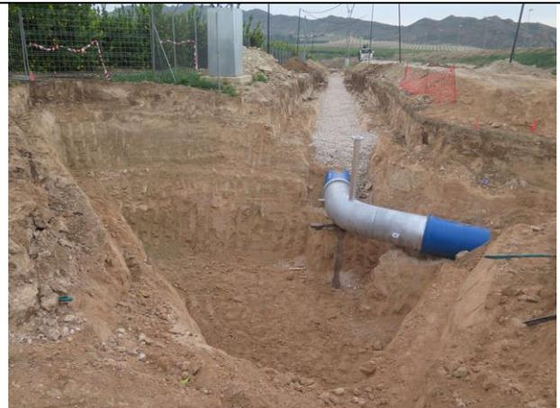
Excavación para encofrar el ángulo que forma la tubería, en un terreno arcilloso anaranjado natural.
