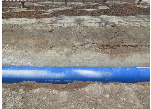
Aspecto de la tubería en la zanja en zona con sedimentos margosos cubiertos por capa de tierra de labor de color gris oscuro.
