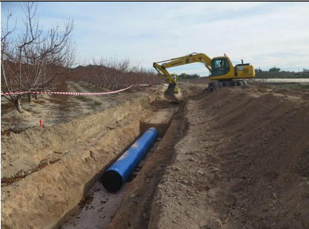
Aspecto de la tubería en el p.k. 1+300 para unir posteriormente con el tramo de la hinca.
