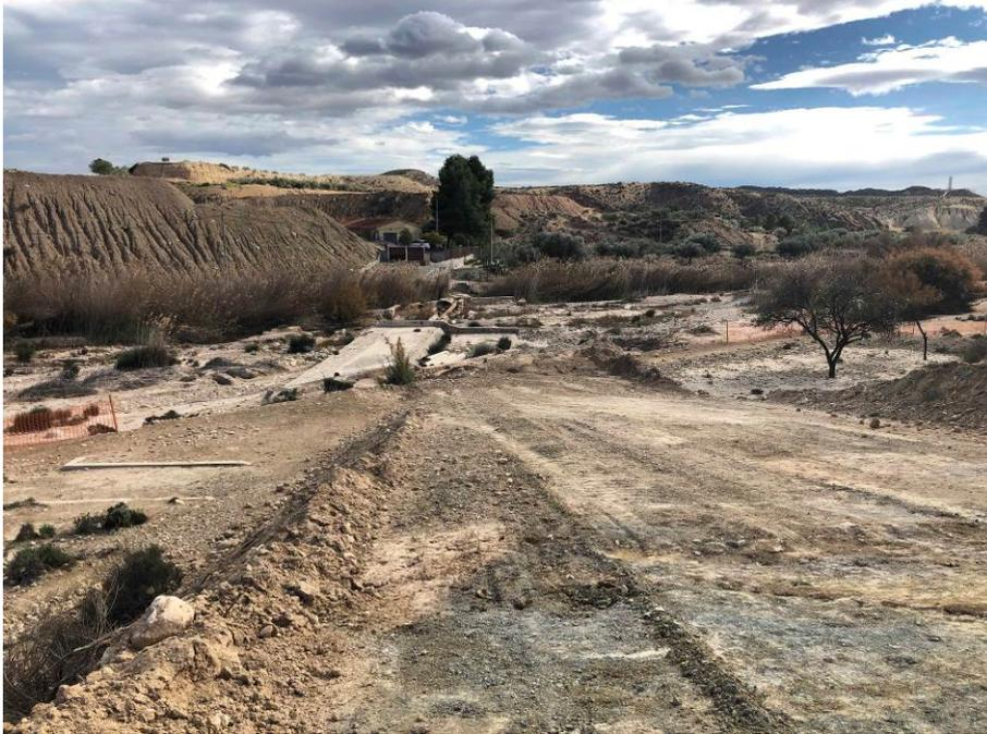
**FOTO 8.** Vista de trabajos de apertura de zanja, tramo de zanja abierta y señalizada en el pk 4,100
