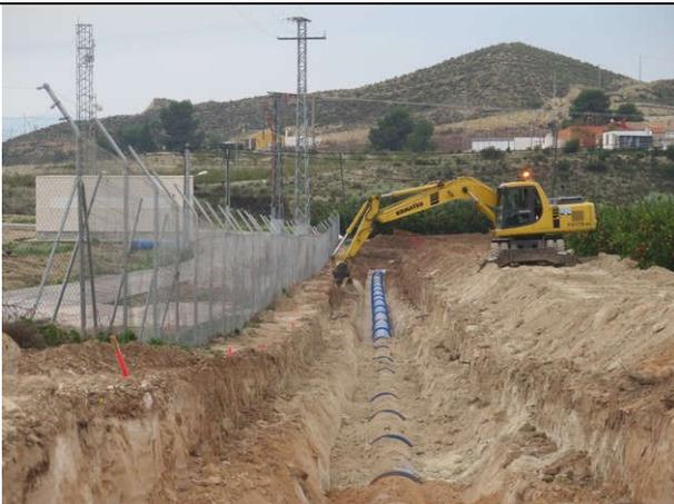
Relleno de tierra sobre la tubería colocada en la parte norte del recinto de la ETAP
