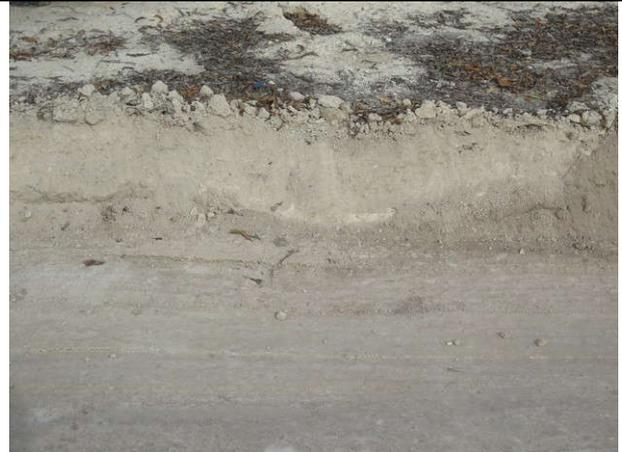
Aspecto del perfil de la zanja con tierra vegetal sobre el terreno compactado de la zanja.
