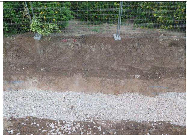
Detalle de la zanja con primer relleno de gravas y sedimentación arcillosa cubierta por sedimentos de naturaleza antrópica agrícola..
