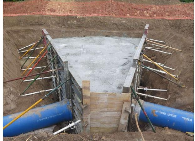
Detalle del encofrado de hormigón con forma de cuña para reforzar una inflexión de la tubería.
