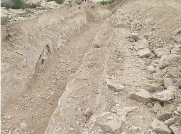
Aspecto de la zanja cruzando los niveles de margas compactadas que fracturan en grandes bloques (derecha).
