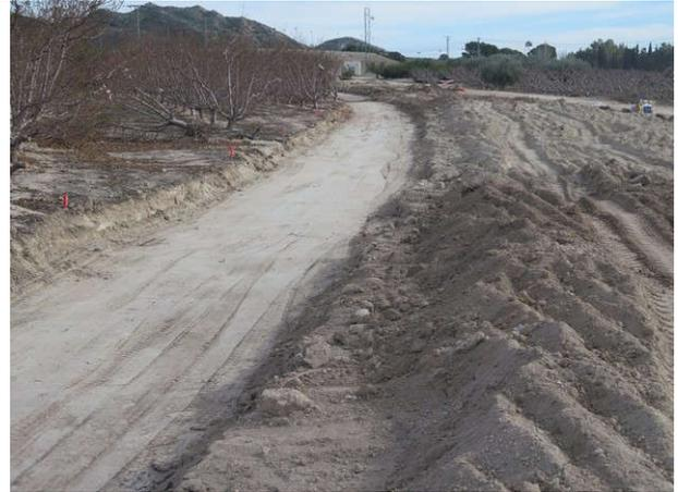
Aspecto de la zanja rellena con sedimentos de la excavación. A la derecha tierra vegetal acopiada.
