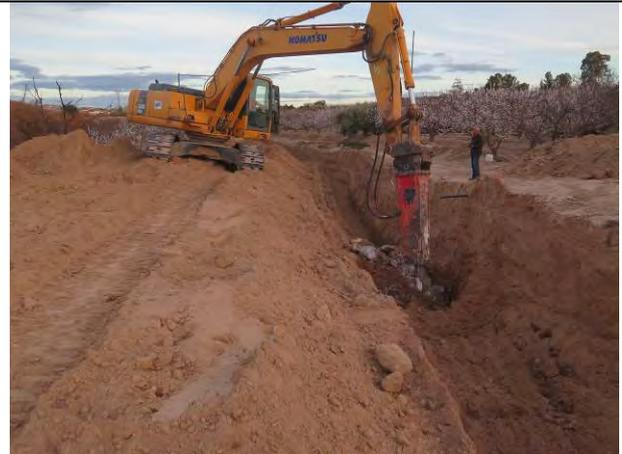
Tramo P.K. 3700- P.K. 4000. Picado con martillo de un gran bloque de caliza aislado.
