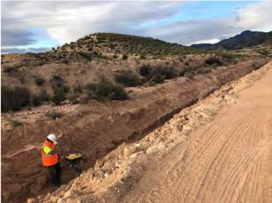
**FOTO 3.** Vista de zona de apertura de zanja en terreno pedregoso, con sustrato muy pulverulento, por la Casa de los Pelegrines.
