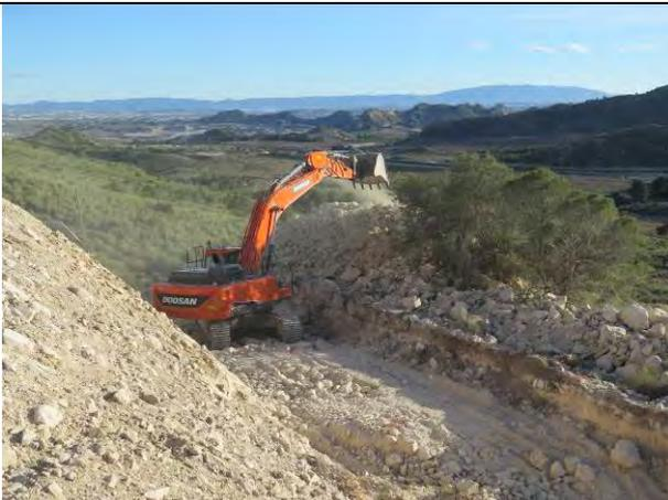
Proceso de construcción de la escollera en la parte baja de la ladera.
