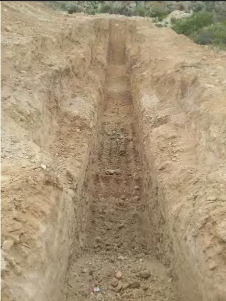
Tramo P.K. 2350- P.K. 2700. Aspecto de la zanja en la margen derecha de la rambla del Carrizalejo, con niveles de arenas, gravas y cantos.
