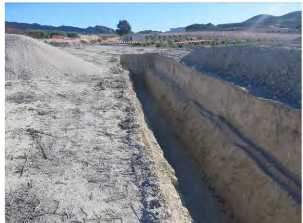
Tramo P.K. 1700- P.K. 2000. Aspecto de la sedimentación natural formado por margas, más consolidadas en profundidad y de textura arenosa en la parte superior.
