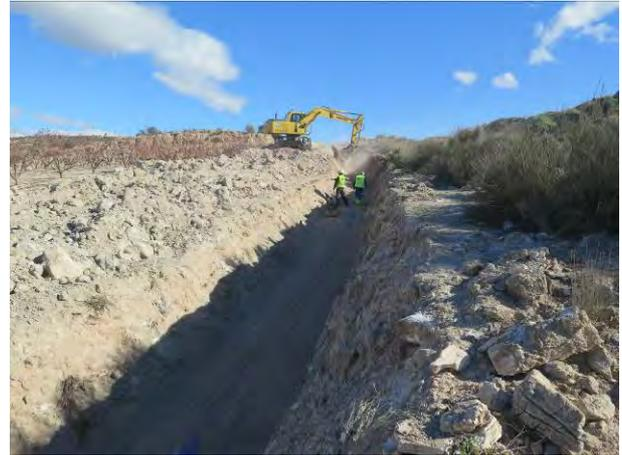
Tramo P.K. 2000- P.K. 2300. Aspecto de la sedimentación natural de la zona, formada por yesos rojizos de textura tabular cubiertos por derrubios de ladera y cantos de rambla.
