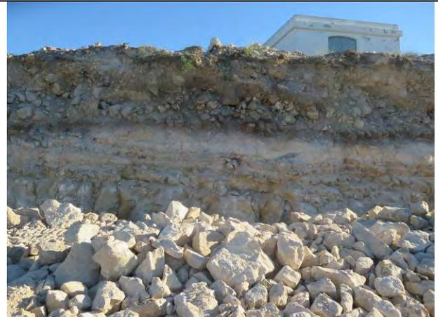
Detalle del perfil estratigráfico del camino. Arriba escombros excavación antigua zanja y debajo calcarenitas estratificadas en tablas.
