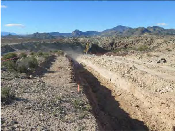
Tramo P.K. 2000- P.K. 2300. Apertura de zanja en tramo en pendiente hacia la rambla del Carrizalejo.
