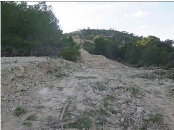
Desbroce en ladera (PK 6+200) hacia el depósito 10000 m3. A la izquierda talud de las antiguas tuberías.
