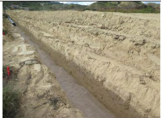
Tramo P.K. 4550- P.K. 4850. Sedimentación natural formada por arenas blanquecinas de textura suelta y compacta en el fondo.
