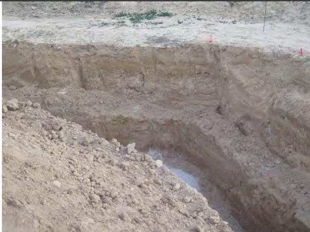
Tramo P.K. 3700- P.K. 4000. Aspecto de la sedimentación compacta y dura formada por arcillas rojo-anaranjado.
