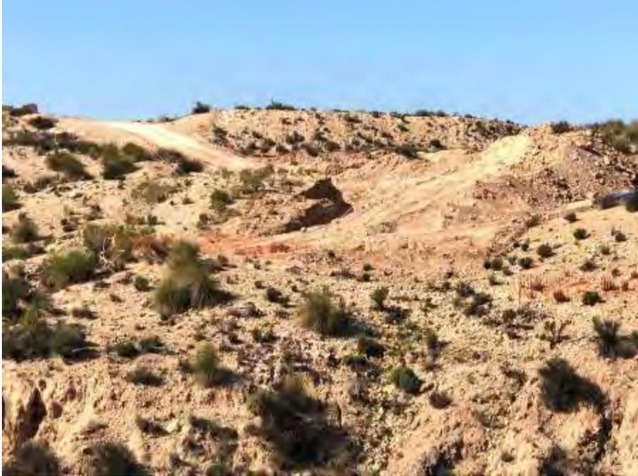
**FOTO 6.** Detalle del final de zanja con pendiente, favorable para que la fauna pueda salir si cae dentro.
