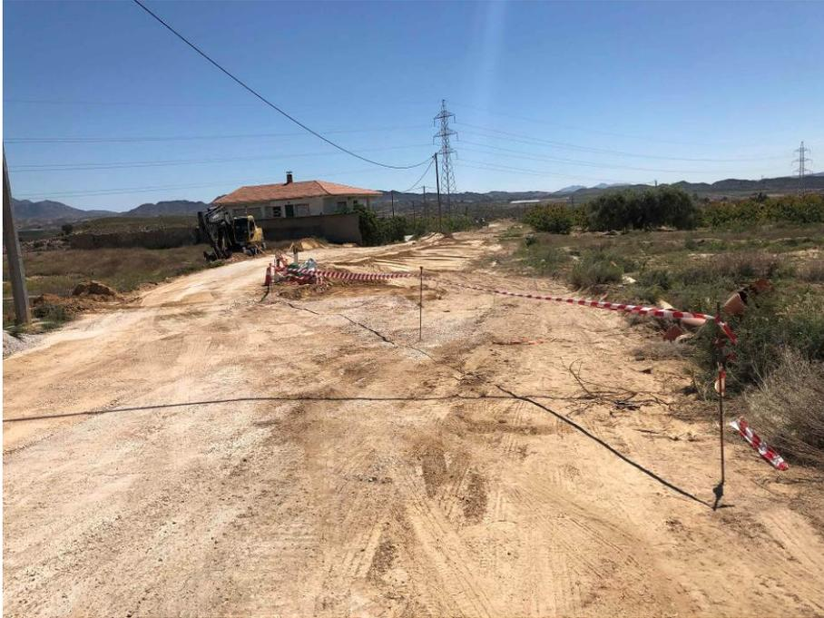
**FOTO 16.** Detalle de rampa al final de una zanja, favorable para la fauna.
