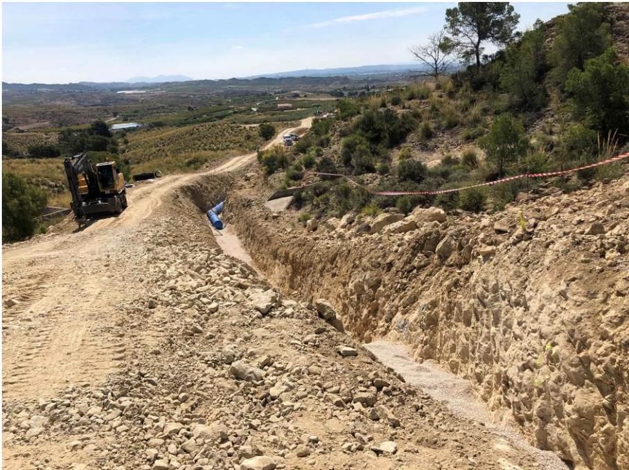
**FOTO 5.** Vista de máquina retroexcavadora taladrando el sustrato rocoso en el pk 5+650.
