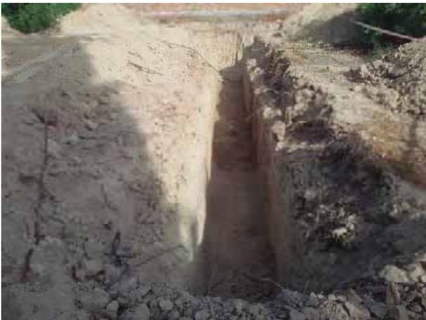
Tramo inicial zanja y relleno grava. Sedimento tierra vegetal arenosa.
