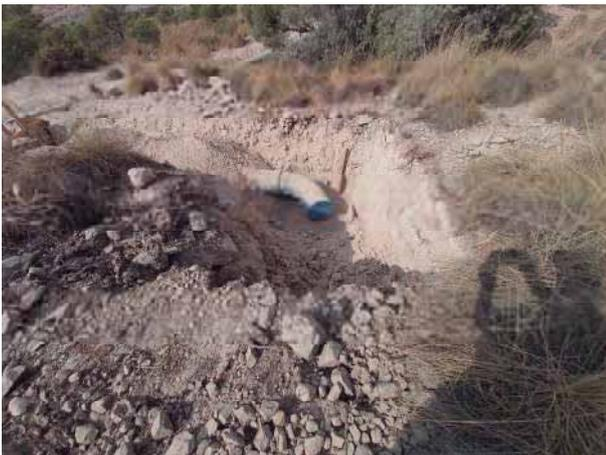
Detalle del codo CH46 en Excavación zanja en P.K. 6+650.
