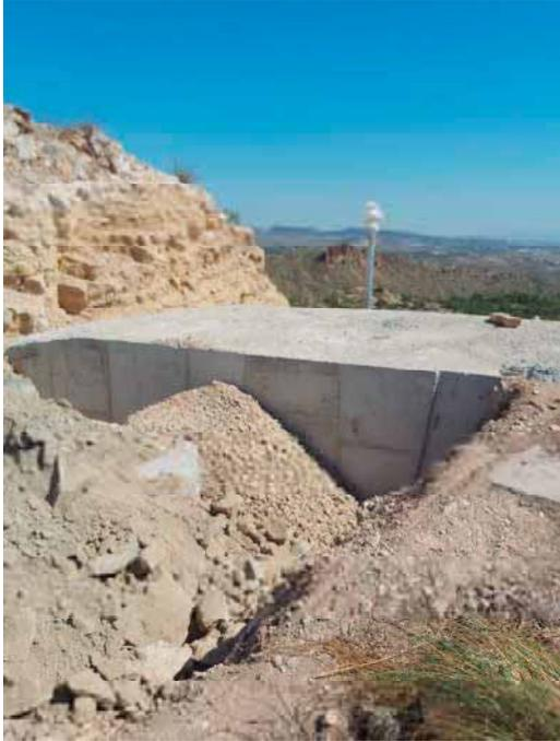
Aspecto del cubo de hormigón sobre codo con aportes de tierras para cubrición P.K. 6+400.
