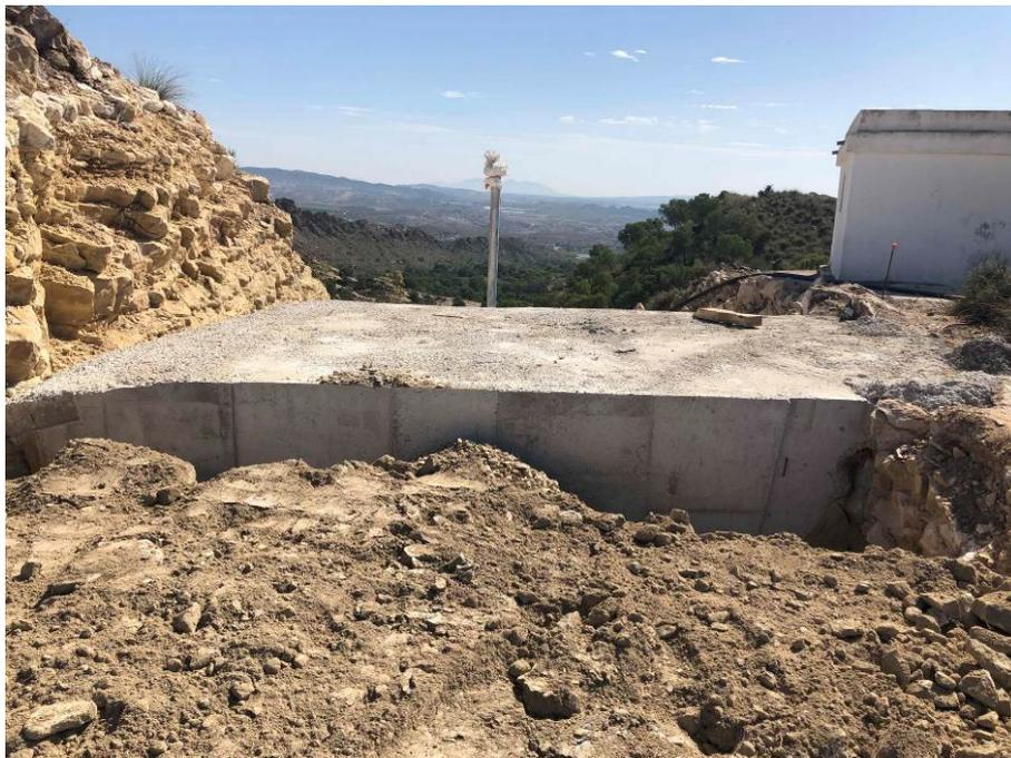
**FOTO 13.** Vista de trabajos de hormigonado de codo en p.k. 6+550
