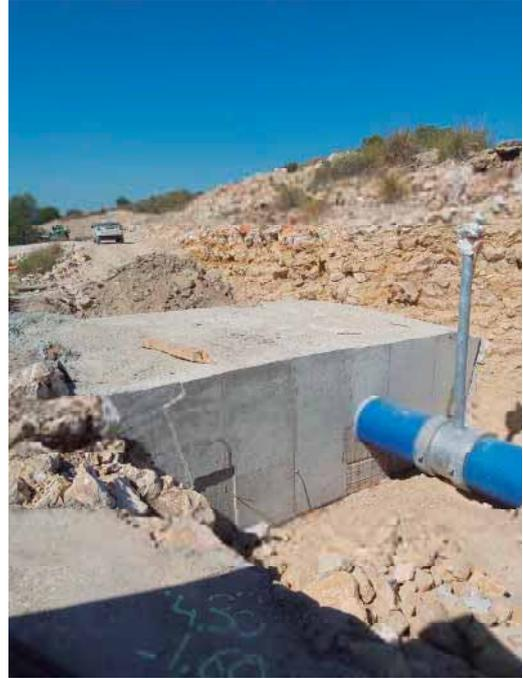
Aspecto dado de hormigón y tubería en el tramo superior hacia depósito P.K. 6+400.
