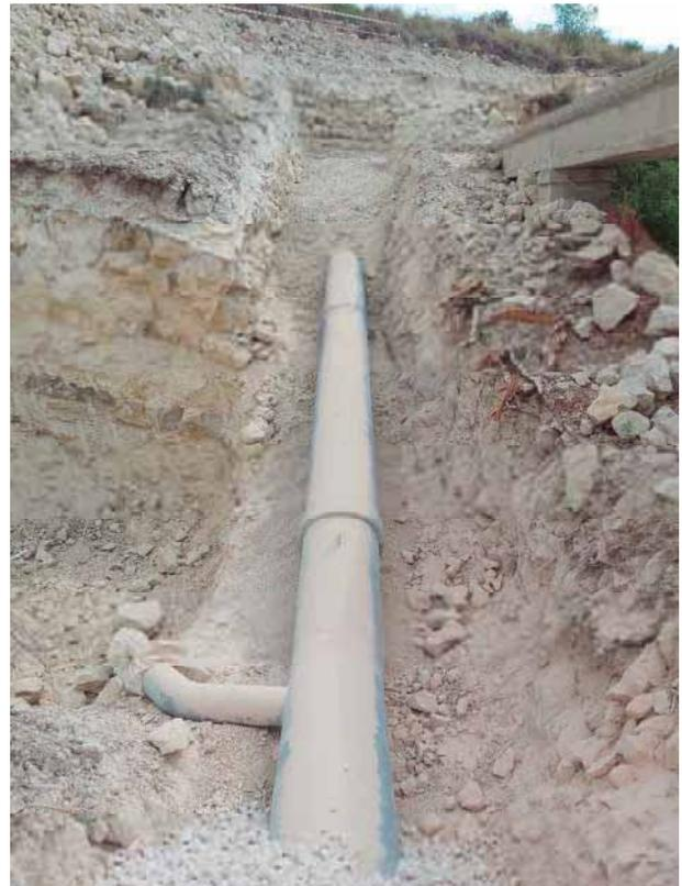
Detalle de la zanja excavada en terrenos margo calizos.
