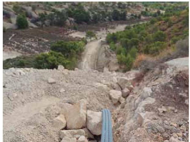
Detalle tritubo en zanja tramo P.K. 6+200-6+400.
