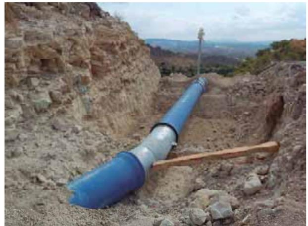
Detalle del codo de la tubería en zanja de margo-calizas.
