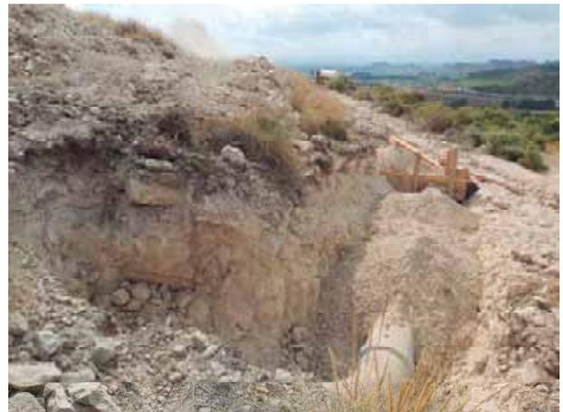
Tramo de tubería en zanja conexión depósito 10000 m3.
