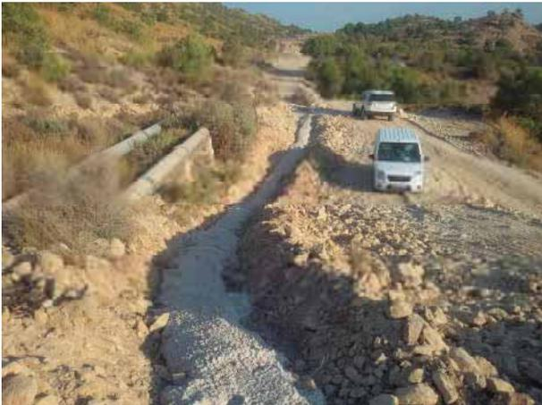
Tritubo recubierto con hormigón de protección.
