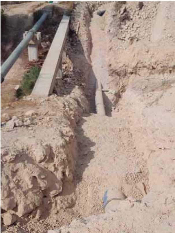
Colocación tubería en zanja cubierta con grava en P.K. 6+550.
