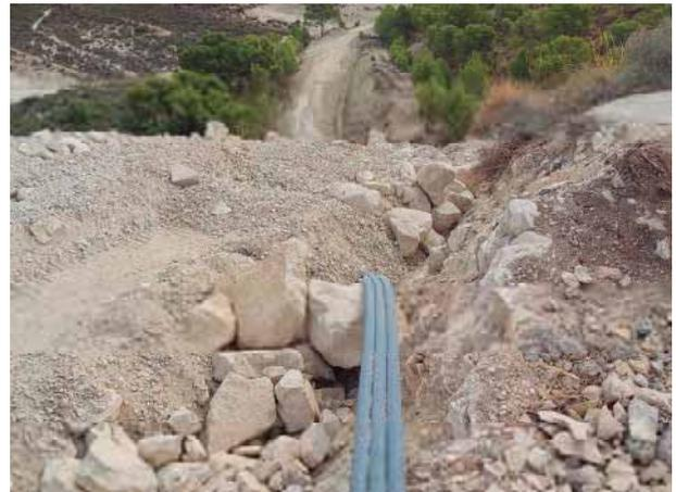
Aspecto de colocación del tritubo en relación a la zanja tubería (izda.).
