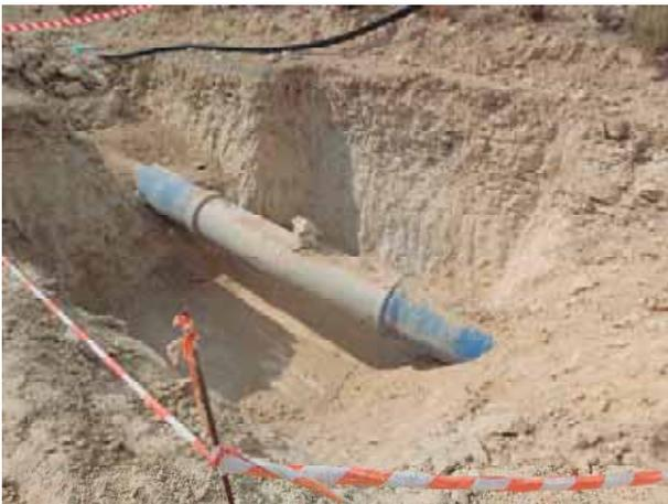
Zanja con excavación para instalación obra de fábrica.
