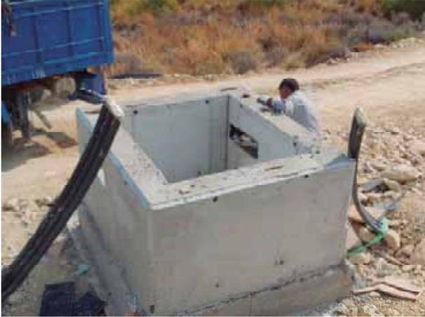
Arqueta de hormigón con instalación de tritubo preparado para inserción.
