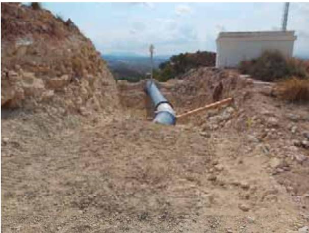
Tramo P.K. 6+350-6+400. Detalle tubería semienterrada.
