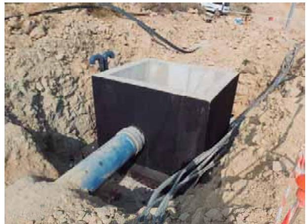
Tubería insertada en arqueta de fábrica.
