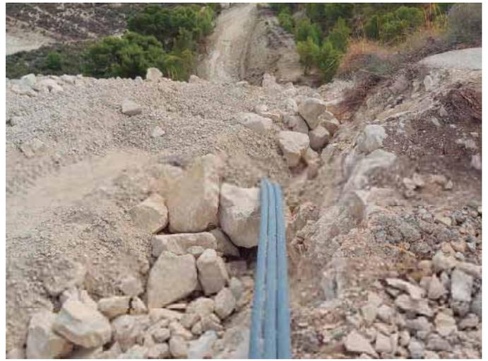
Aspecto de la colocación del tritubo junto tubería tapada en P.K. 6+400.
