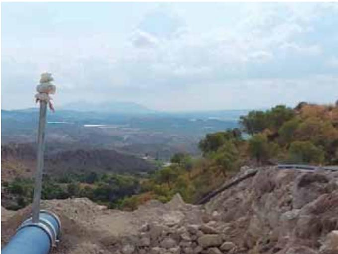
Tubería en zanja con instalación de tritubo preparado para inserción P.K. 6+400.
