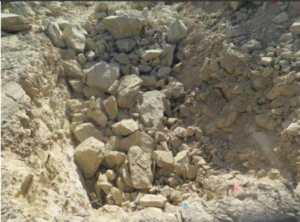
Tramo P.K. 5000- P.K. 6050. Bloques de margo-calizas en proceso de excavación.
