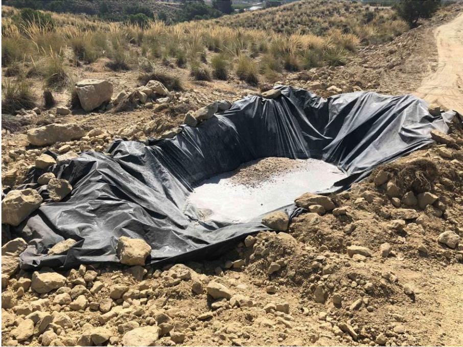
**FOTO 36.** Acopio de residuos de aglomerado asfáltico junto al pk 4+540, antes de ser retirado.
