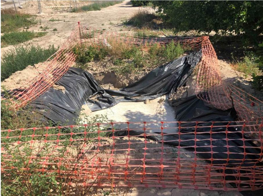
**FOTO 34.** Detalle de limpieza de canaleta en una balsa impermeabilizada, en pk 2+000, que carece de señalización e identificación.
