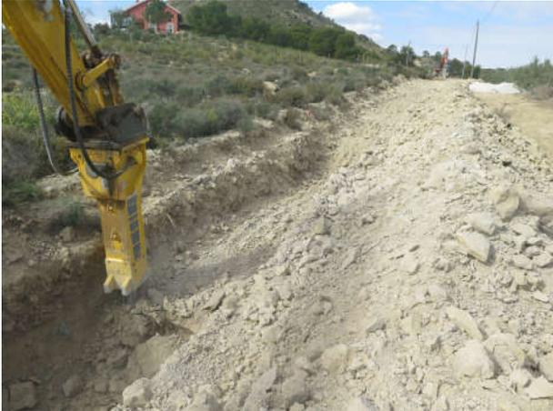
Tramo P.K. 5000- P.K. 6050. Excavación zanja en terrenos duros de mago-calizas consolidadas.
