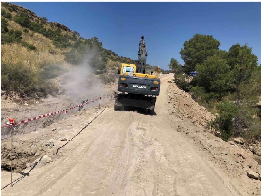
**FOTO 19.** Vista de riego con cisterna en zona de excavación para reducir las emisiones de polvo a la atmósfera.
