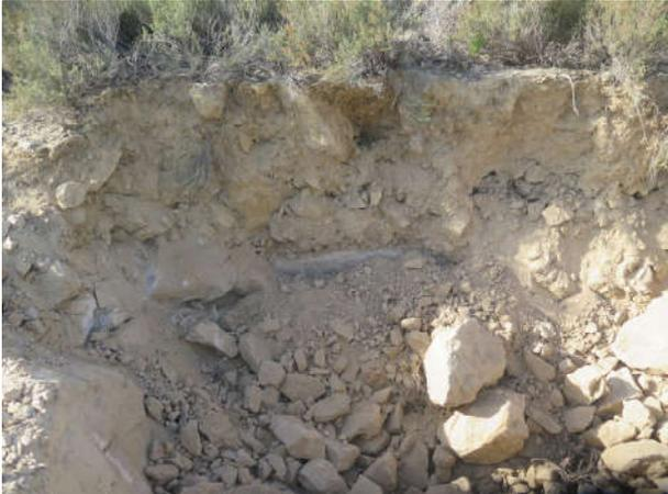
Tramo P.K. 5000- P.K. 6050. Cata lateral para localización conducción antigua en terrenos sueltos de relleno.
