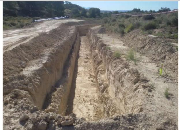
Tramo P.K. 6050. Estado final de la zanja en las proximidades de la ladera de ascenso al depósito de 10000 m3.
