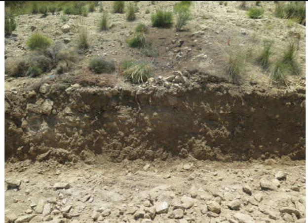
Tramo P.K. 5000- P.K. 6050. Aspecto del desmonte lateral preparatorio de la zanja
