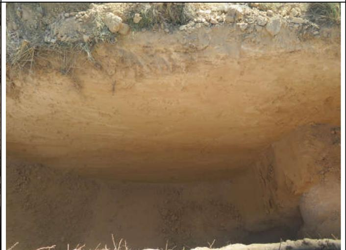
Detalle de la cata con localización de tubería. Sedimentación arenosa natural con manto de tierra vegetal de cultivo en el techo.
