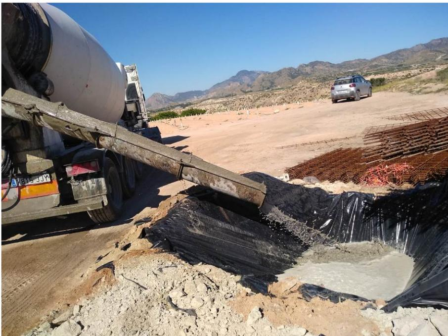
**FOTO 35.** Recinto de limpieza de canaletas en pk 5+370 a falta de señalización e identificación.
