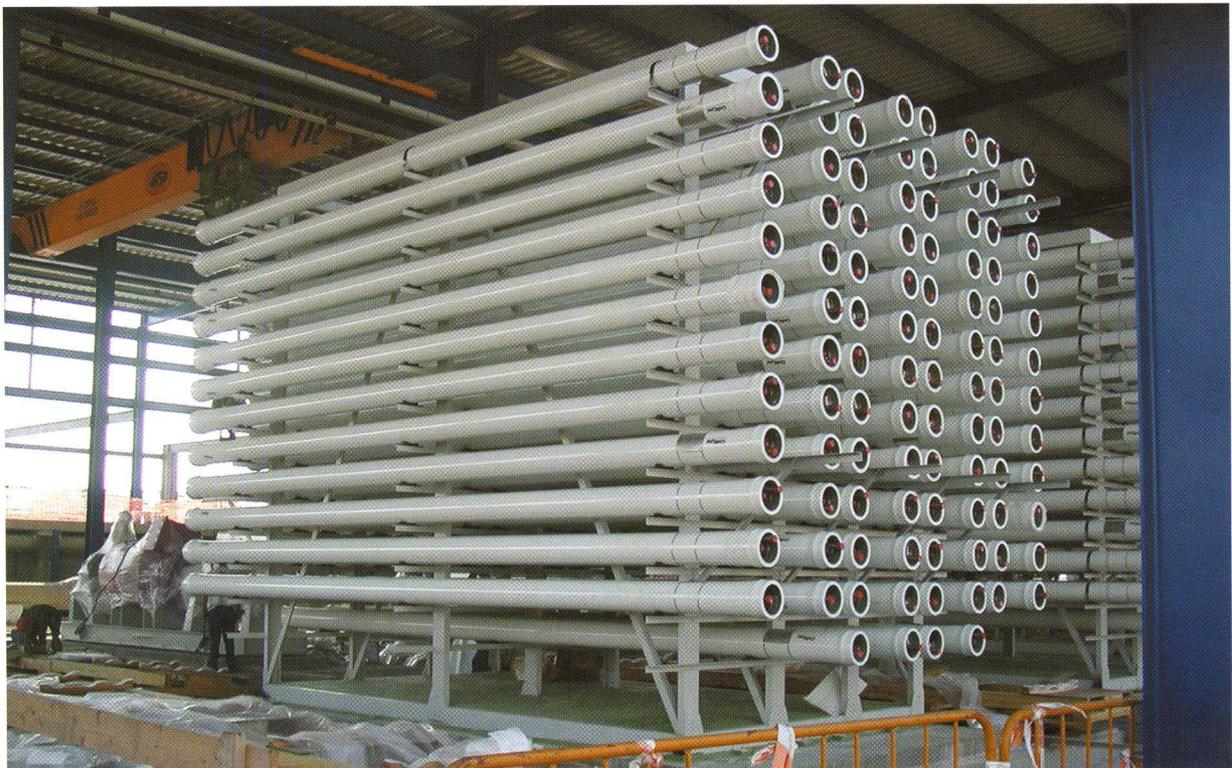
DESALADORA DEL CANAL DE ALICANTE (BASTIDOR DE TUBOS DE MEMBRANAS DE ÓSMOSIS INVERSA)
