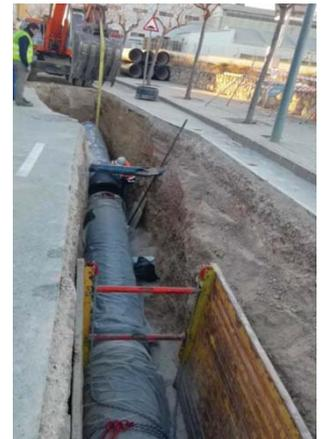
La actuación pretende terminar de renovar la traza del actual ramal C1-Bis, sustituyendo los tramos existentes de tubería de fibrocemento con DN 600 mm, que han producido costosas averías, por una nueva tubería de fundición dúctil de 700 mm de diámetro.
