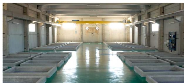
Imagen 13. Instalación de lechos de calcita en la IDAM de Alicante II, en la que se produce la remineralización del agua desalinizada.
