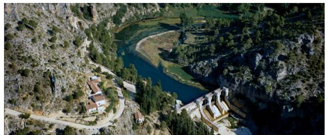
Imagen 5. Presa de la Toma (1942), situada abajo del Estrecho del Aire, en el río Taibilla, actúa como dispositivo de entrada, por aliviadero, al origen del Canal Alto del Taibilla. Su construcción se inició en 1934.
