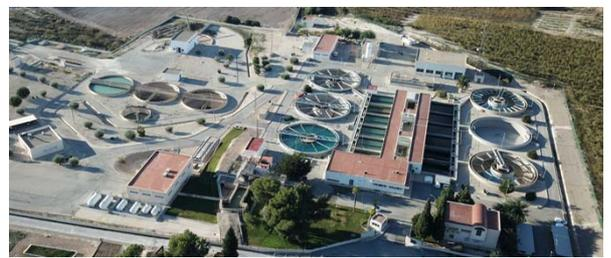
**Imagen 10.** ETAP de Campotéjar (1978 Molina del Segura, provincia de Murcia). En el año 2022 se ha redactado el proyecto para su digitalización y automatización y han continuado las obras para adaptar su funcionamiento a la reducción de los recursos continentales.
