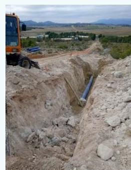
Una nueva tubería DN300 de fundición dúctil y longitud de 1.926 m paralela al Ramal de Calasparra, en cuyo final se ejecutará una conexión con tubería DN200 de 177 metros hasta la arqueta de derivación en el recinto del nuevo depósito.
