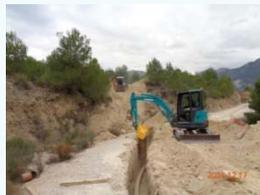
El trazado de esta nueva conducción discurre en su mayor parte paralelo a la pista forestal existente, que debido a la existencia de otras conducciones (saneamiento y riego) ha sido preciso su ampliación, habiendo sido necesario realizar desmontes de la ladera.
