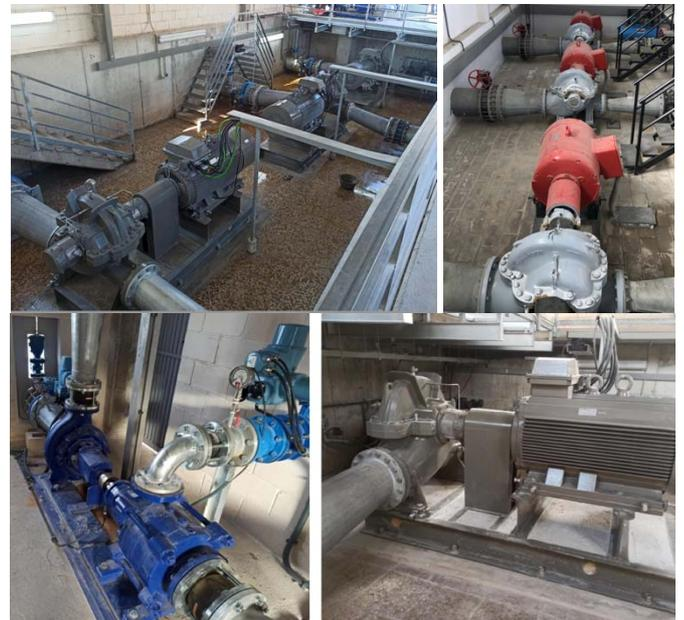
Imagen 23. Imágenes de las obras finalizadas en 2022 en las elevaciones de Apolonia y San Vicente, cofinanciadas con fondos europeos (FEDER 2014-2020, que han consistido principalmente en la sustitución de las bombas existentes por unas nuevas más adecuadas a las instalaciones actuales.
