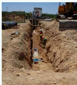
**Actuaciones principales:** Las obras han consistido en la sustitución de uno de los tubos de fibrocemento de la conducción existente entre el canal de Cartagena y el depósito rectangular de los Cánovas, así como también una "Nueva Toma" de la tubería de que sale del depósito de "Las Cuevas de Reylo", con el fin de dar mayor versatilidad de maniobra para abastecer el depósito de "Los Cánovas".
