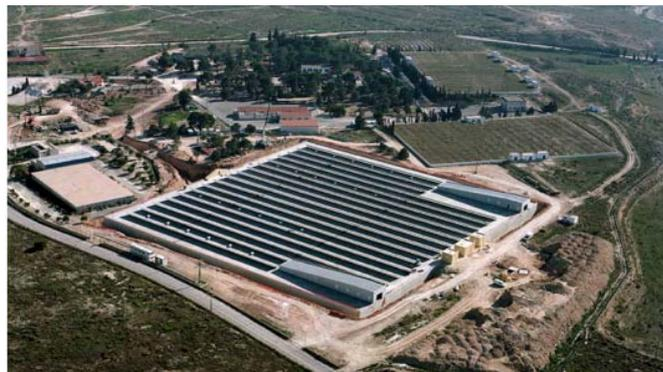
*Imagen 16.* Vista de la instalación fotovoltaica en la cubierta del depósito de Rabasa (Alicante). Ésta fue la primera instalación fotovoltaica (de 797,64 kWp). Se trata de la única planta del organismo cuya producción se destina íntegramente a la venta de energía.
