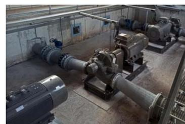
**Imagen 28.** Nuevos equipos electromecánicos instalados en la elevación de Apolonia (Lorca) para la mejora de la eficiencia energética.
