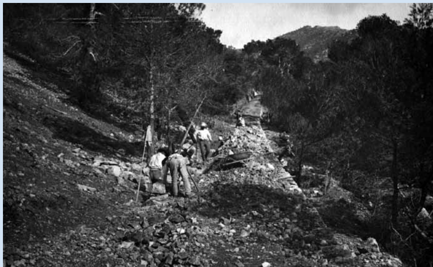
Entre 1891 y 1897 se acondicionaron muchos de los caminos y senderos hoy existentes en España. En 1896 estaban así las obras de este sendero cerca del barranco del Ciruelo. Totana. Archivo DGMA
