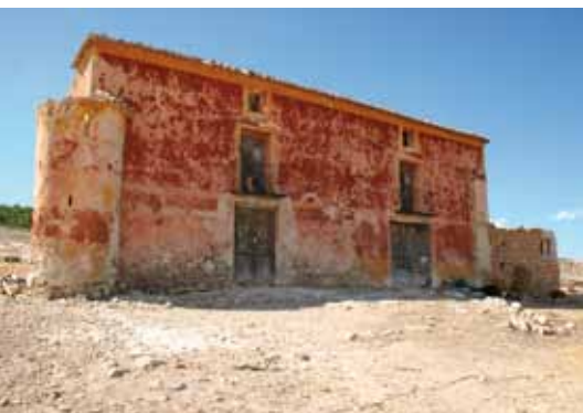
Casa de Las Garitas. MAG
