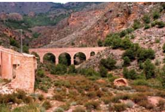
Canal del Taibilla. La Calzona. MAG
