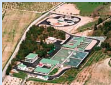
Estación Potabilizadora de Letur. mct.es
