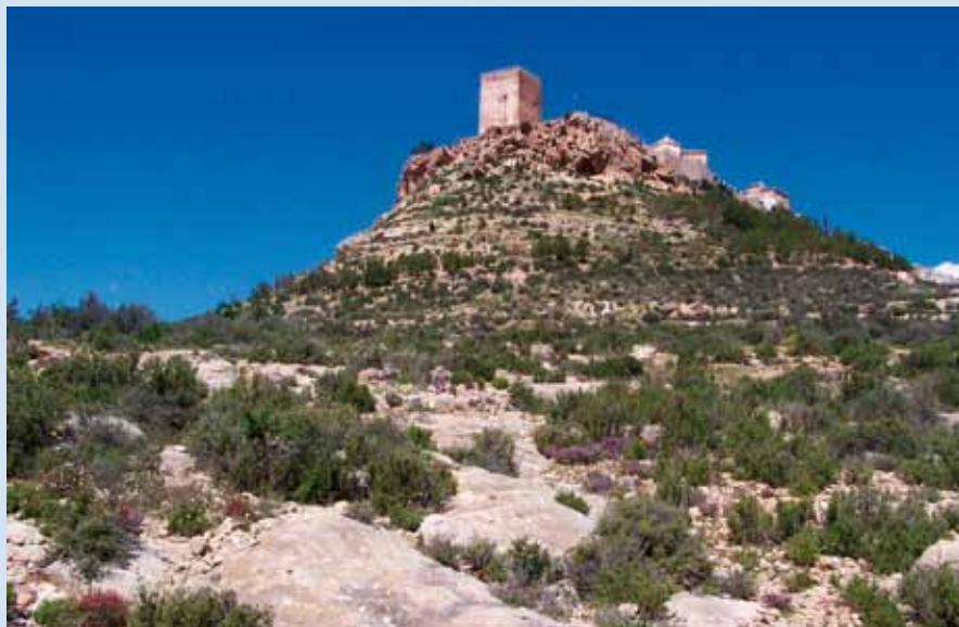
Torre de la Calahorra de Aledo. BDC
