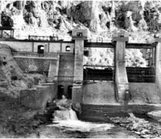
Presa de Toma, 1945. mct.es
