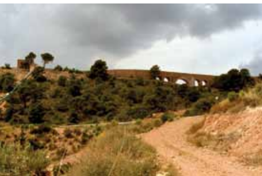
Acueducto del Canal del Taibilla en el Rápido de Totana. MAG
