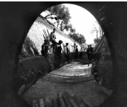
Túnel del Roble. mct.es
