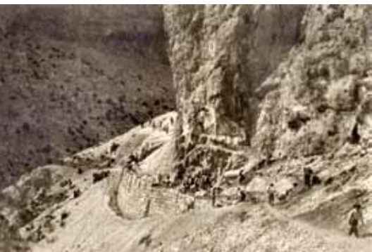
Camino de servicio a la presa de toma. 1932. mct.es
