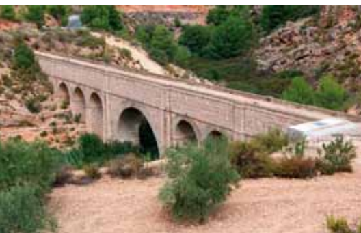
Acueducto del Taibilla sobre la rambla de Algeciras. MAG
