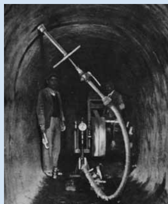
A la izquierda, canal de sección normal. A la derecha, inyecciones de cemento en el túnel de Pinohermoso. MCT.es
