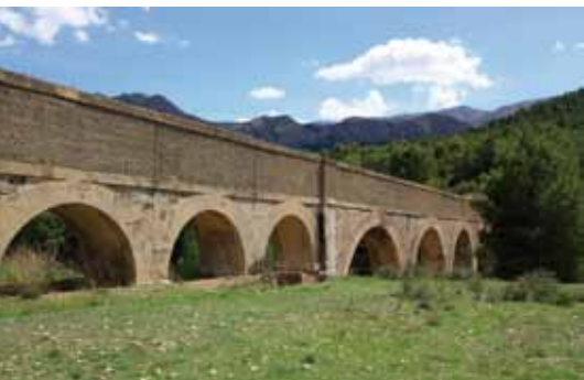
Acueducto sobre el barranco de Malvariche, primer punto de contacto del Canal con sierra Espuña. Casas Nuevas. MAG
