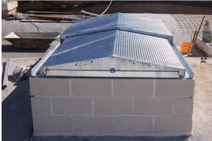
DETALLE DE PUERTAS CORREDERAS TELESCÓPICAS DESMONTABLES PARA ACCESO DE MAQUINARIA
