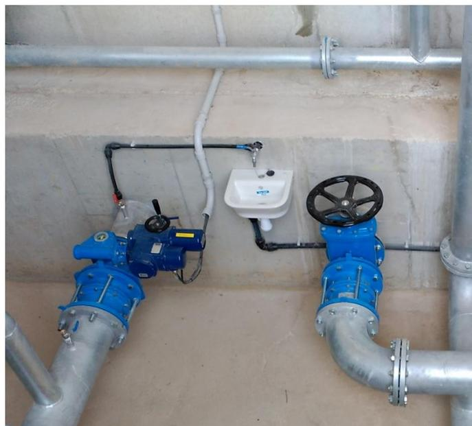
TOMA DE MUESTRAS EN TUBERÍA DE SALIDA (CON TUBO DE ADUCCIÓN)
