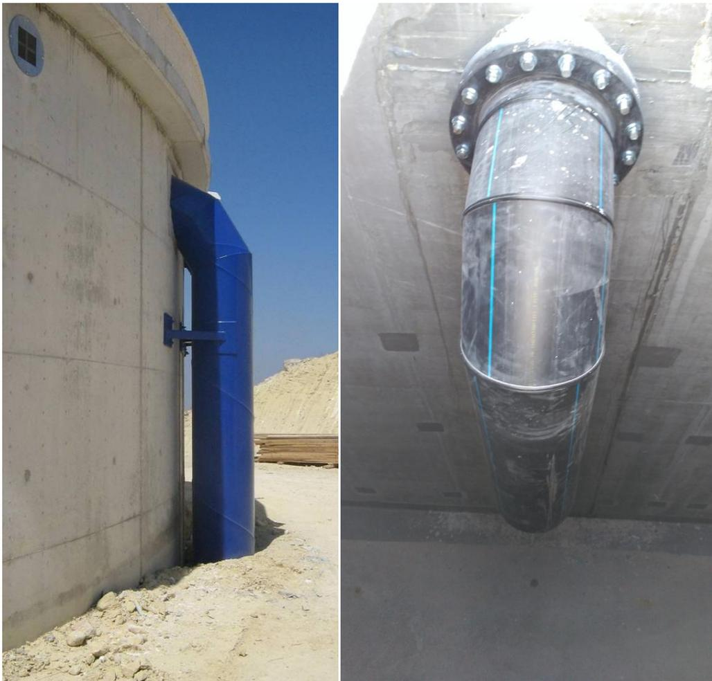
TUBERÍA DE ENTRADA DE AGUA Y DETALLE DE ENTREGA INTERIOR
