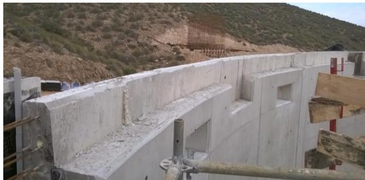
PRETIL IN SITU EN DEPÓSITO CIRCULAR CON CAJEO DE APOYO DE VIGAS Y VENTANAS
